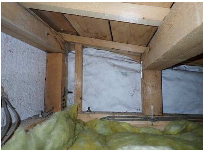
小屋裏 木材の腐朽度D 腐朽は見られない 写真番号 1
