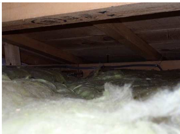
小屋裏 木材の腐朽度D 腐朽は見られない 写真番号 6
