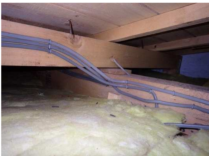
小屋裏 木材の腐朽度D 腐朽は見られない 写真番号 5
