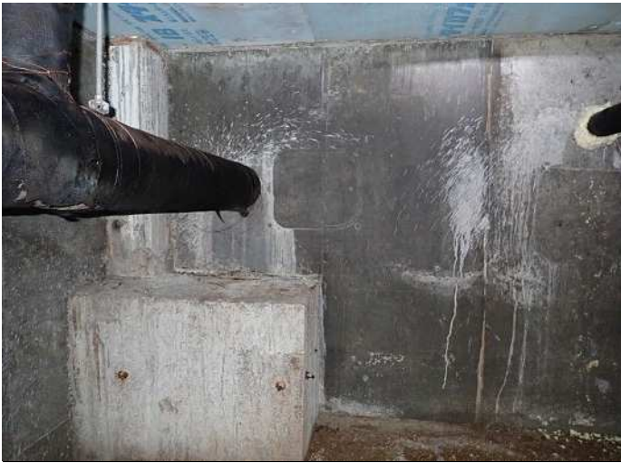
ピット内部 基礎構造β 外周部状況 写真番号 9
