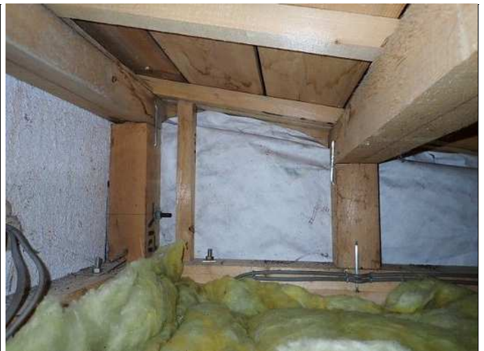
小屋裏 接合金物状況 羽子板ボルト及びびかすがいが使用されている 写真番号 4
