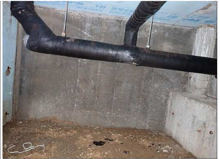
ピット内部 基礎構造β 外周部状況 写真番号 10
