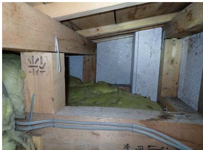
小屋裏 木材の腐朽度D 腐朽は見られない 写真番号 4
