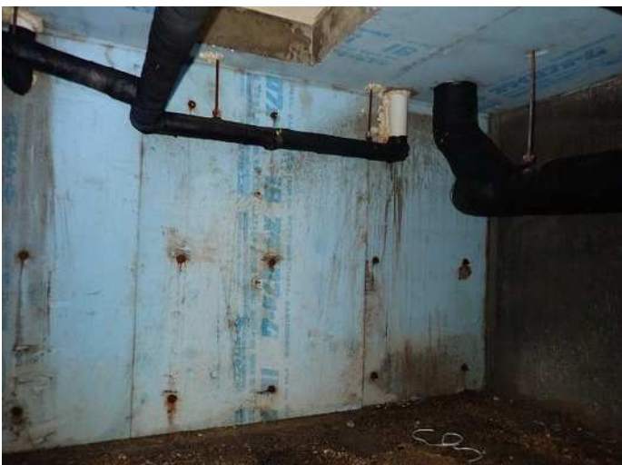
ピット内部 基礎構造β 13-1棟との接合部状況 写真番号 11
