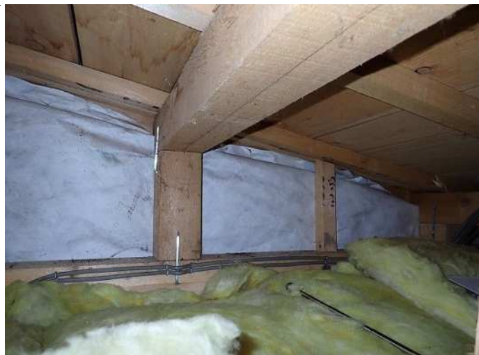
小屋裏 木材の腐朽度D 腐朽は見られない 写真番号 2
