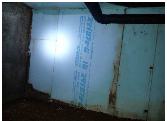
ピット内部 基礎構造β 13-1棟との接合部状況 写真番号 12
