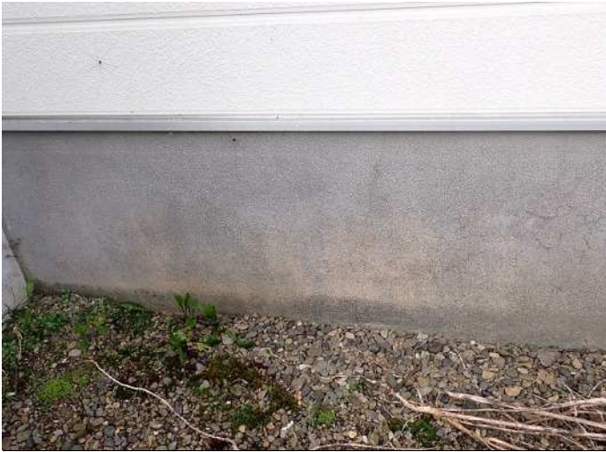
基礎 基礎の状態F 幅0.3mm未満のひび割れが部分的にみられる 写真番号 1
