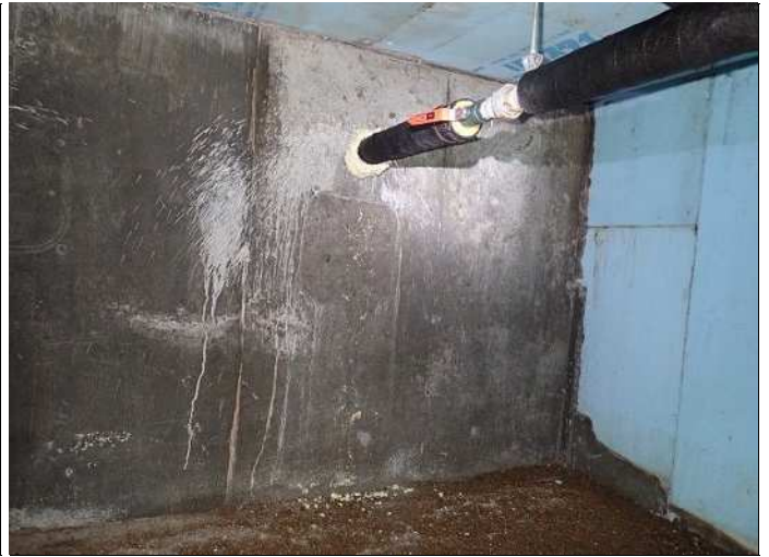
ピット内部 基礎構造β 外周部状況 写真番号 8
