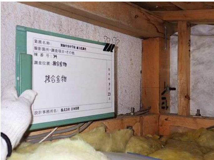
小屋裏 接合金物状況 羽子板ボルト及びびかすがいが使用されている 写真番号 3
