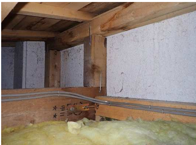
小屋裏 木材の腐朽度D 腐朽は見られない 写真番号 3
