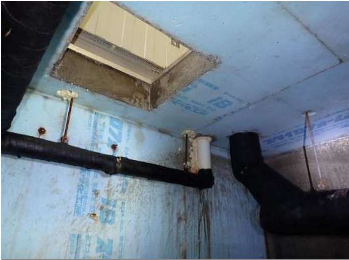
ピット内部 基礎構造β ピット出入口状況 写真番号 7
