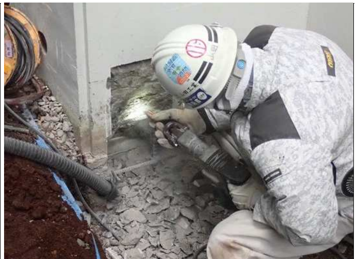
はつり状況 写真番号 4
