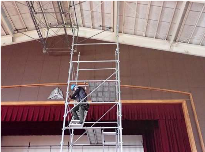
足場設置状況(1) 写真番号 1
