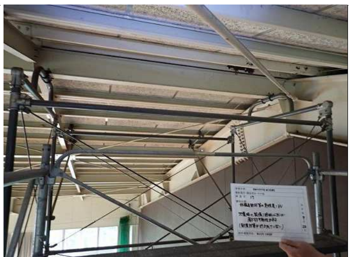
地震時に設備(照明以外)が落下する可能性がある (耐震対策が行われていない) 写真番号 6
