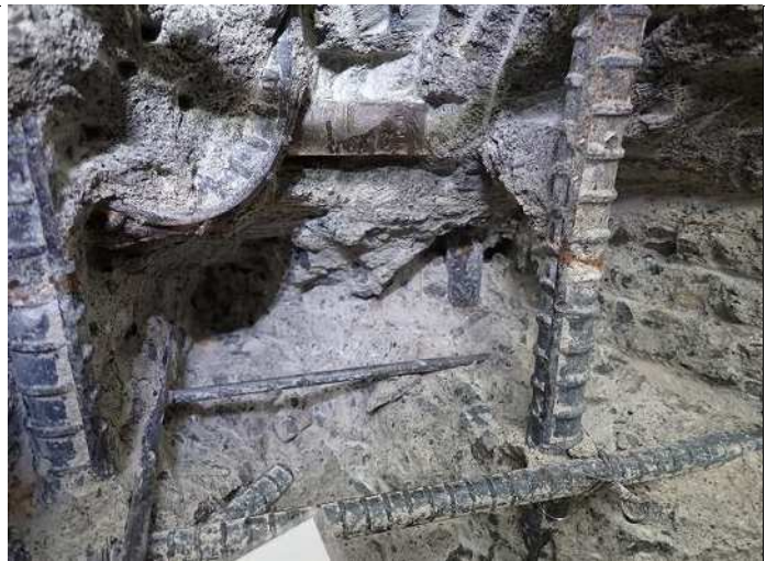
主要構造部材(柱脚) 写真番号5詳細(1) 写真番号 6
