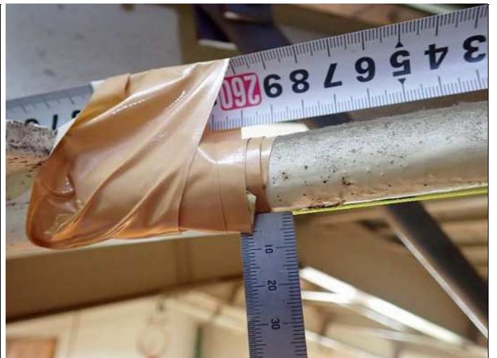
梁間方向 測定用水系設置部終点 水系との距離0mm 写真番号 9
