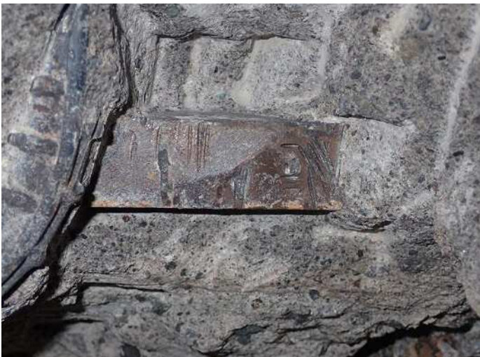
主要構造部材(柱脚) 写真番号5詳細(2) 写真番号 7
