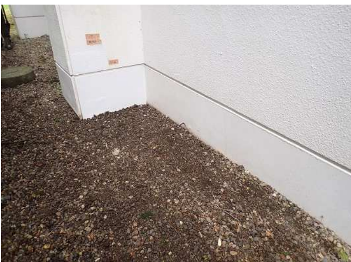
復旧完了 写真番号 5
