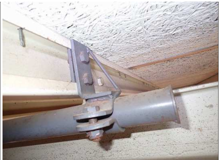
写真番号6詳細(4) 写真番号 10
