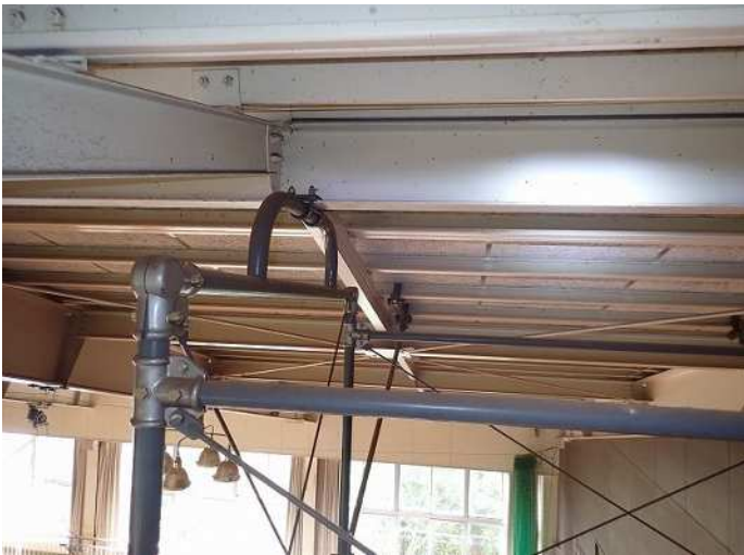
写真番号6詳細(1) 写真番号 7
