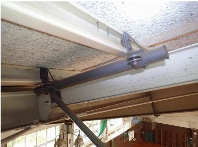
写真番号6詳細(3) 写真番号 9
