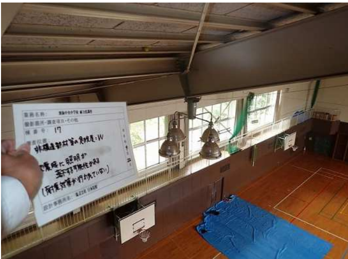
地震時に照明が落下する可能性がある (耐震対策が行われていない) 写真番号 3
