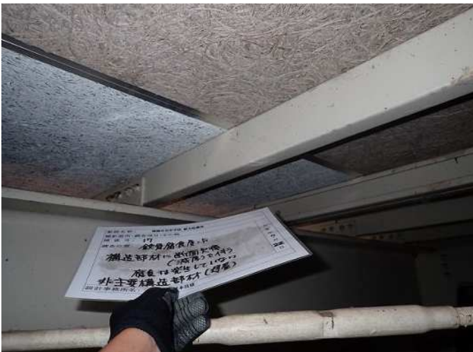
非主要構造部材(母屋) 断面欠損(減厚)を伴う腐食は発生していない 写真番号 11
