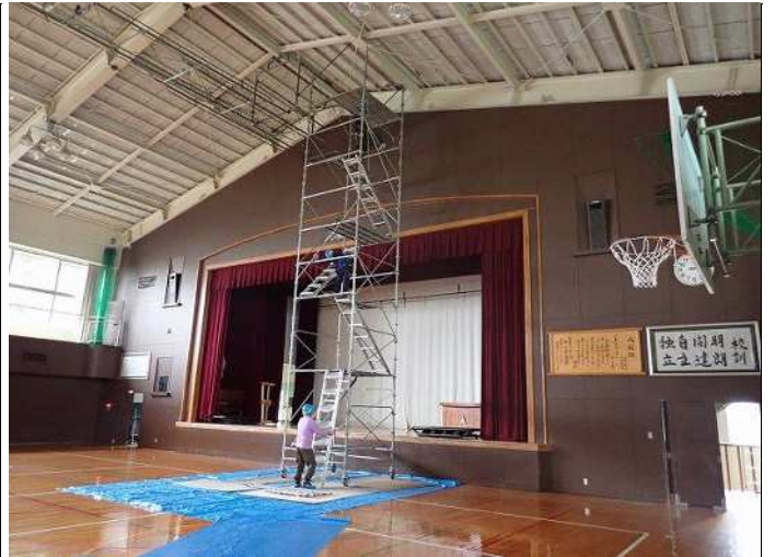
足場設置状況(2) 写真番号 2
