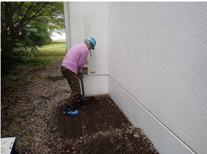
掘削状況 写真番号 3
