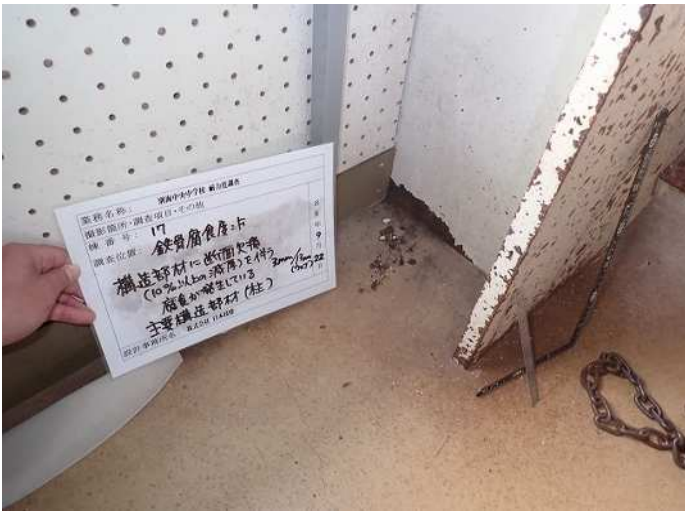
主要構造部材(2F柱) 断面欠損(10%以上の減厚)を伴う腐食が発生している 写真番号 1
