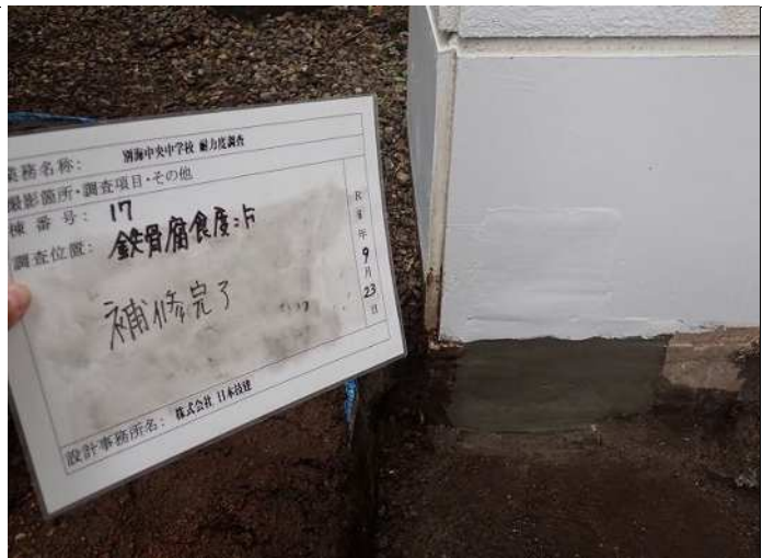
主要構造部材(柱脚) 補修完了 写真番号 8
