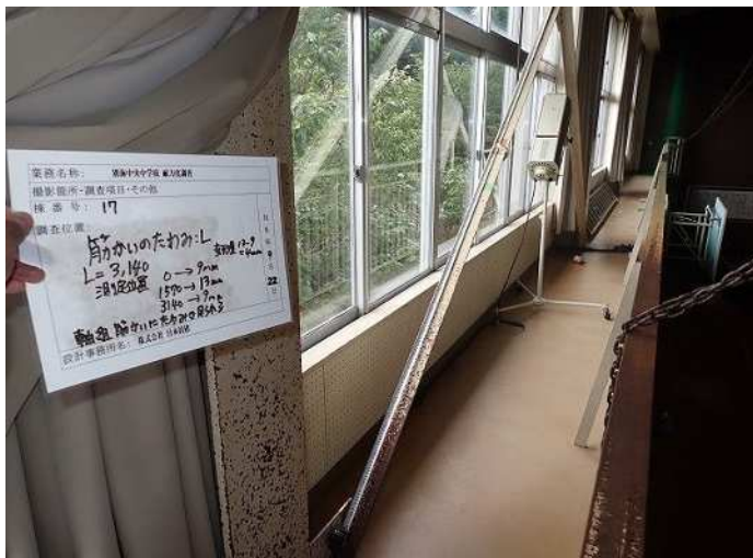
桁行方向 たわみ有 測定長さ=3140mm,変形量=4mm 写真番号 1
