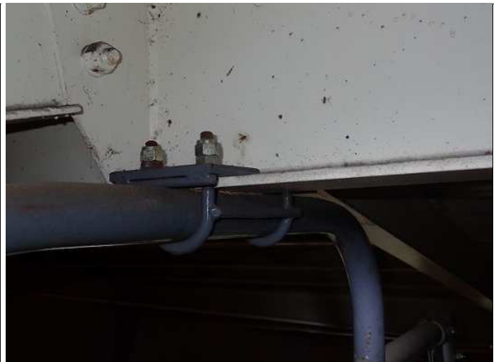
写真番号6詳細(2) 写真番号 8
