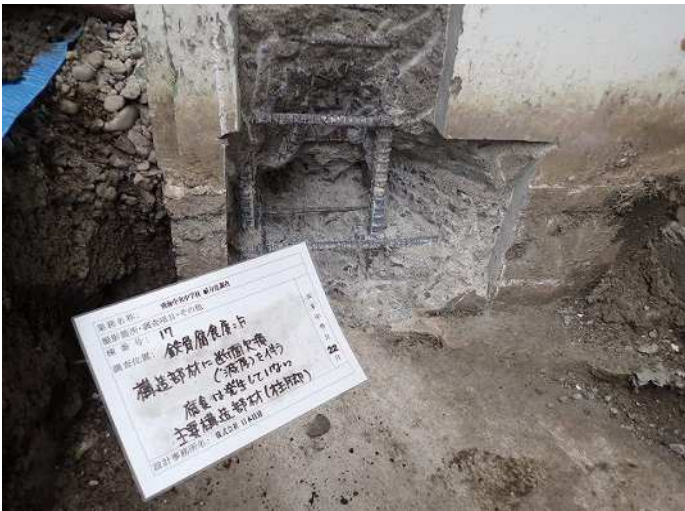
主要構造部材(柱脚) 断面欠損(減厚)を伴う腐食は発生していない 写真番号 5
