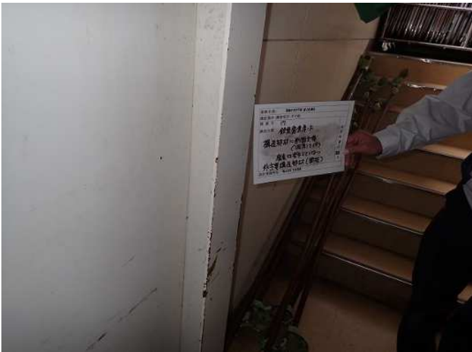
非主要構造部材(間柱) 断面欠損(減厚)を伴う腐食は発生していない 写真番号 9
