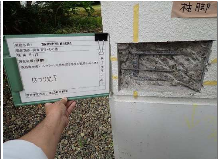
柱脚・柱2 はつり完了 写真番号 13
