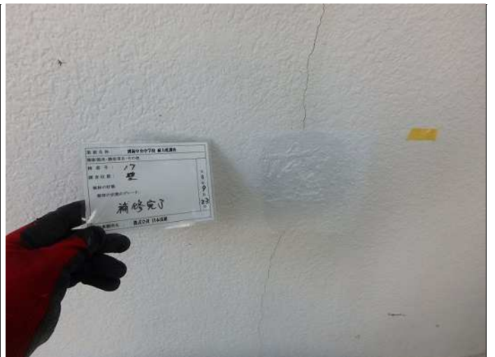
壁 躯体の状態D 補修完了 写真番号 6
