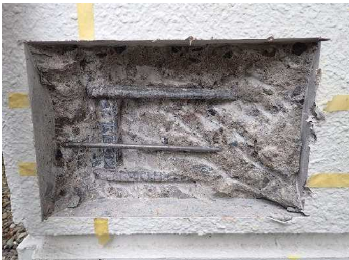
柱脚・柱2 写真番号13詳細 写真番号 14
