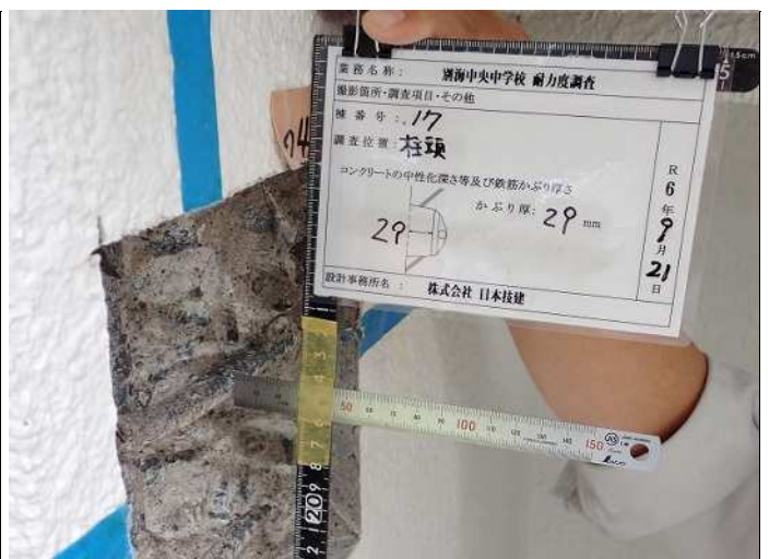
柱頭・柱1 鉄筋かぶり厚さb かぶり厚:2.9cm 写真番号 6
