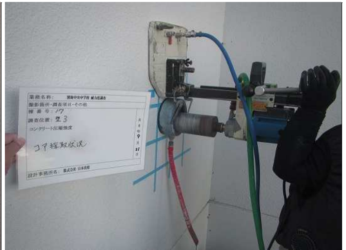
壁3 コンクリート圧縮強度k コア採取状況 写真番号 14
