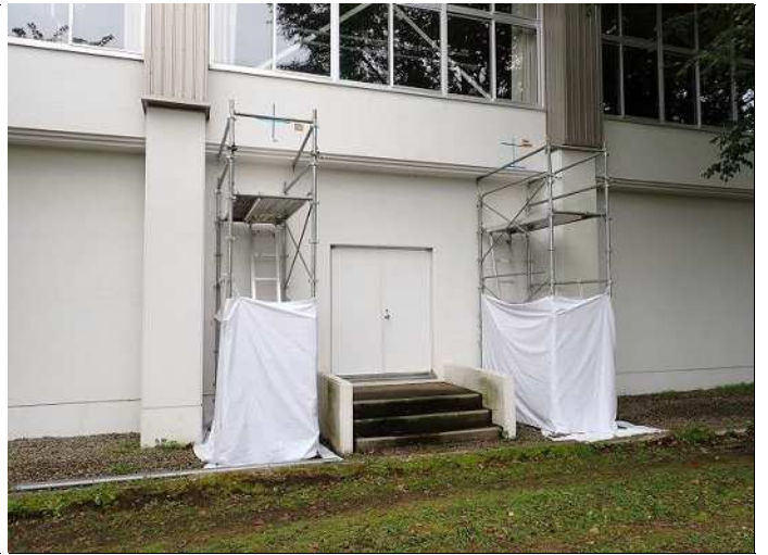
梁1, 梁2 足場設置完了 写真番号 48
