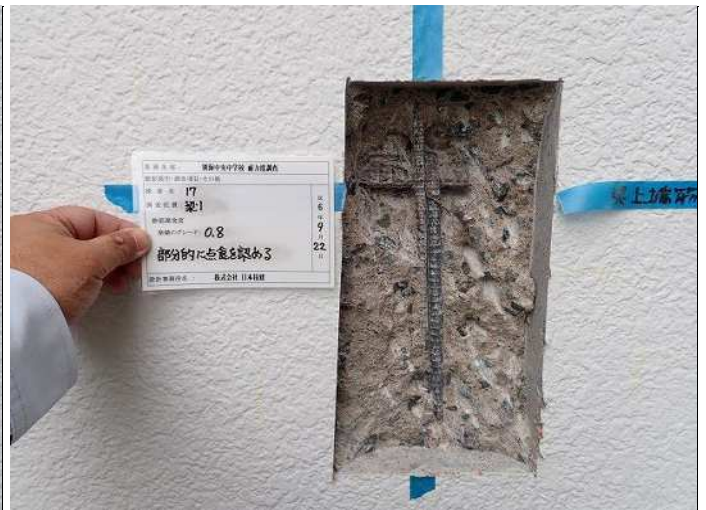
梁1 鉄筋腐食度F 部分的に点食を認める(グレード0.8) 写真番号 26
