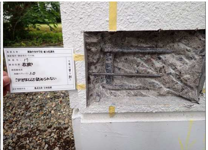
柱脚・柱2 鉄筋腐食度F さびがほとんど認められない(グレード1.0) 写真番号 15
