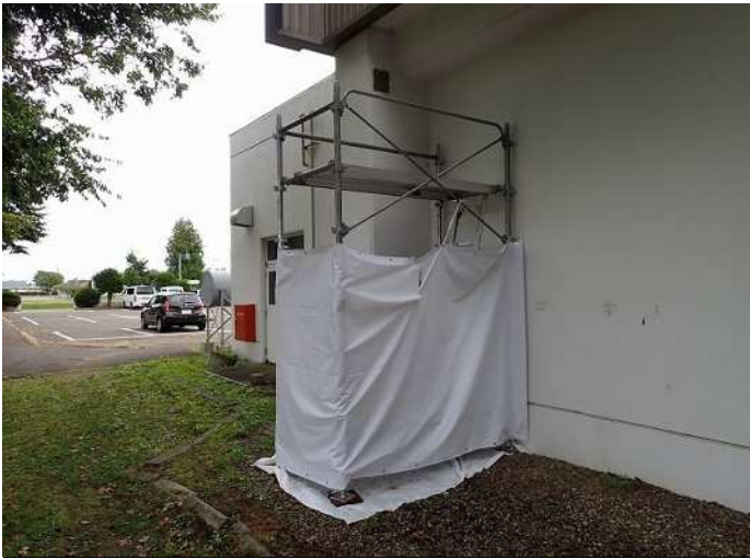
柱頭・柱1 足場設置完了 写真番号 47
