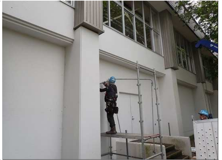
柱頭・柱1 足場設置・解体状況 写真番号 46
