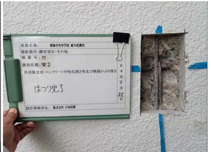
梁2 はつり完了 写真番号 35
