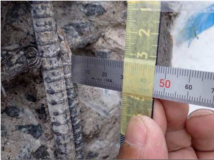
梁2 鉄筋かぶり厚さb 写真番号39詳細 写真番号 40
