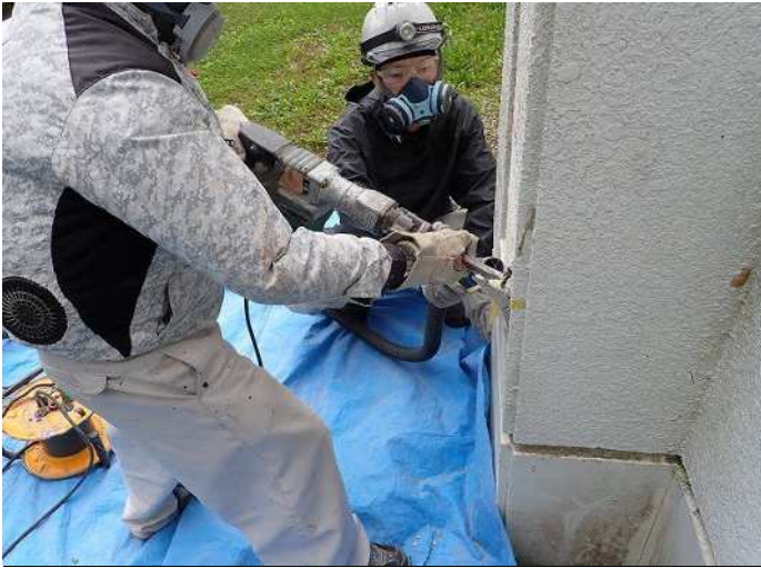
柱脚・柱2 はつり状況 写真番号 45
