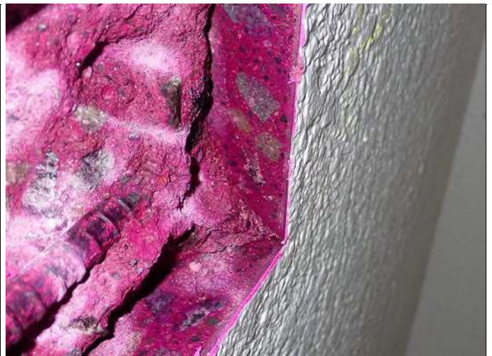
柱頭・柱1 コンクリート中性化深さa 写真番号8詳細(2) 写真番号 10
