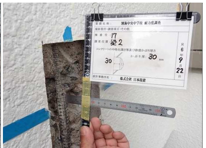
梁2 鉄筋かぶり厚さb かぶり厚: 3.0cm 写真番号 39
