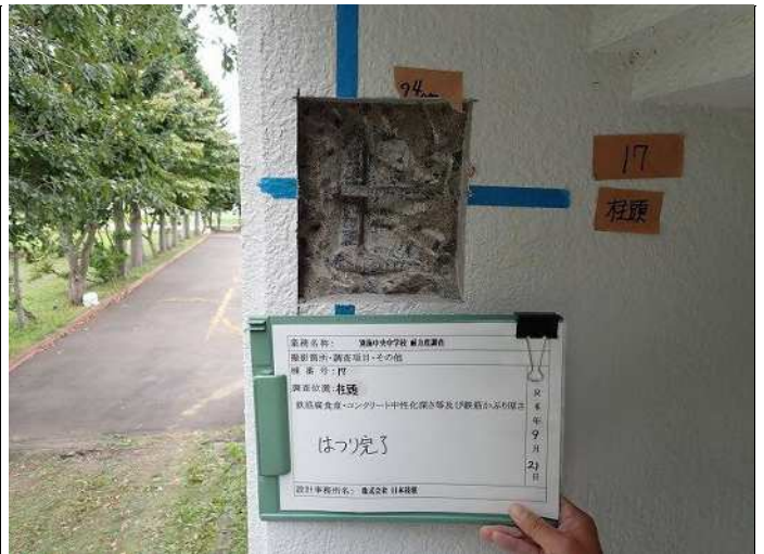
柱頭・柱1 はつり完了 写真番号 2
