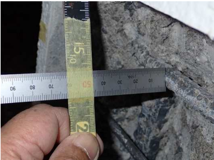
柱脚・柱2 鉄筋かぶり厚さb 写真番号17詳細 写真番号 18
