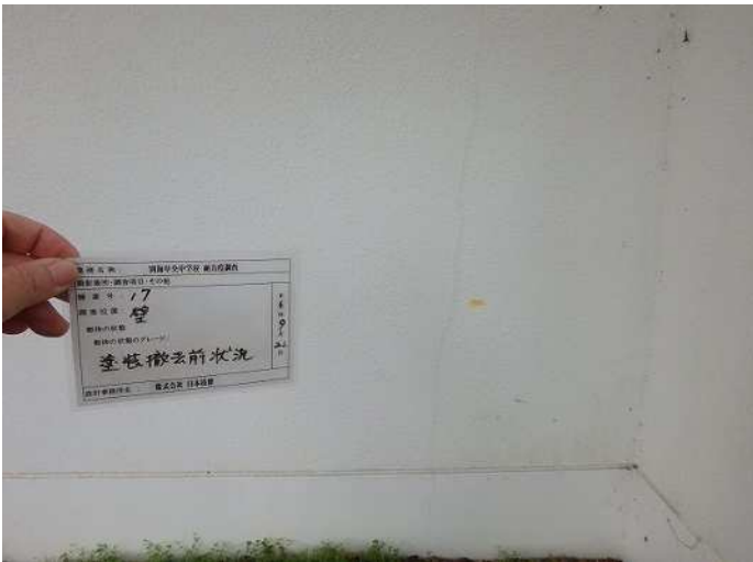
壁 躯体の状態D 塗装撤去前状況 写真番号 3
