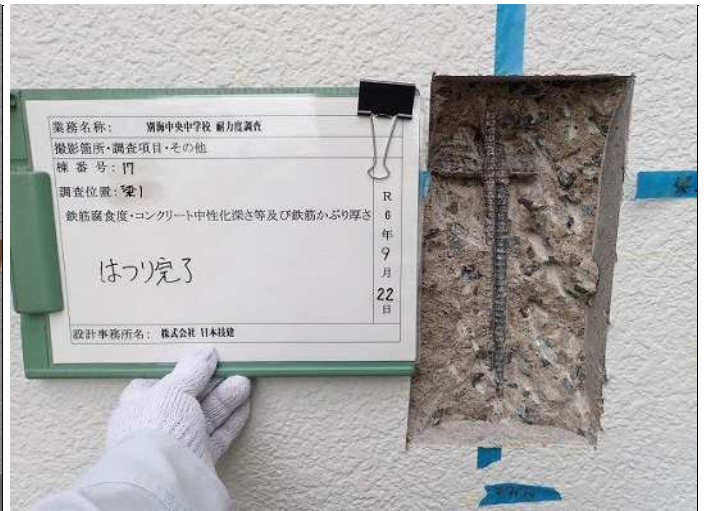
梁1 はつり完了 写真番号 24
