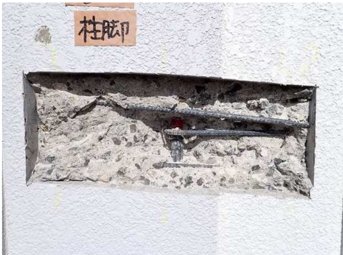
柱脚・柱2 写真番号14詳細 写真番号 15
