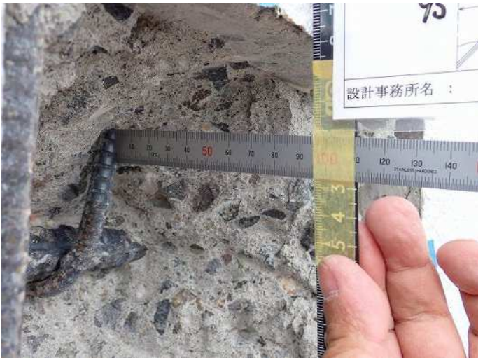
梁2 鉄筋かぶり厚さb 写真番号41詳細(1) 写真番号 42
