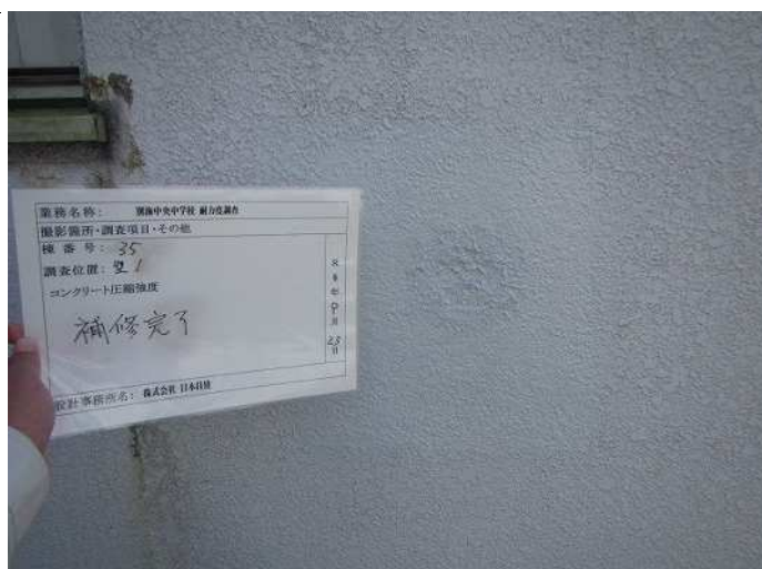
壁1 コンクリート圧縮強度k 補修完了 写真番号 4
