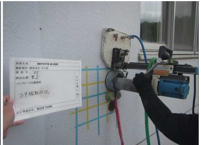
壁2 コンクリート圧縮強度k コア採取状況 写真番号 8
