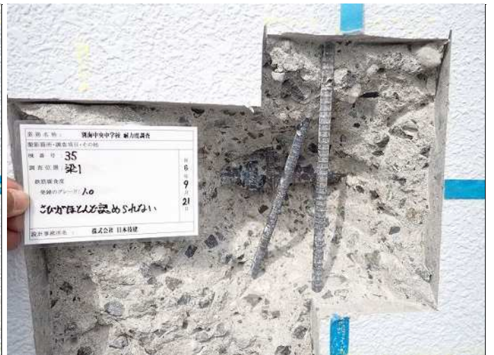
梁1 鉄筋腐食度F さびがほとんど認められない(グレード1.0) 写真番号 27
