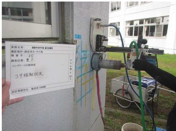
壁1 コンクリート圧縮強度k コア採取状況 写真番号 2
