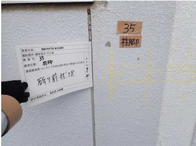
柱脚・柱2 はつり前状況 写真番号 13
