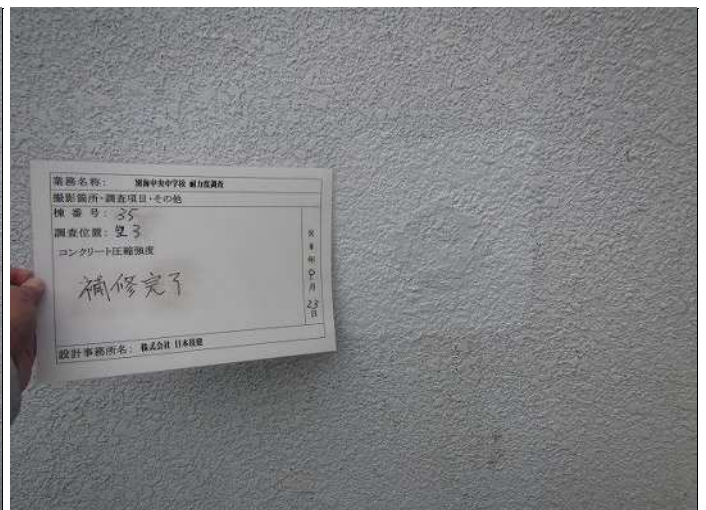
壁3 コンクリート圧縮強度k 補修完了 写真番号 16
