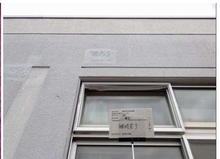
梁2 補修完了 写真番号 47
