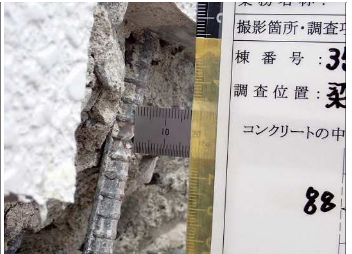
梁1 鉄筋かぶり厚さb 写真番号29詳細(2) 写真番号 31
