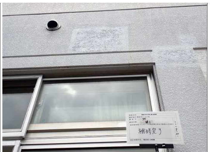
梁1 補修完了 写真番号 35
