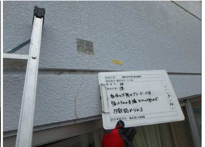
梁 躯体の状態D 幅0.3mm未満のひび割れが多数認められる(グレード0.8) 写真番号 4
