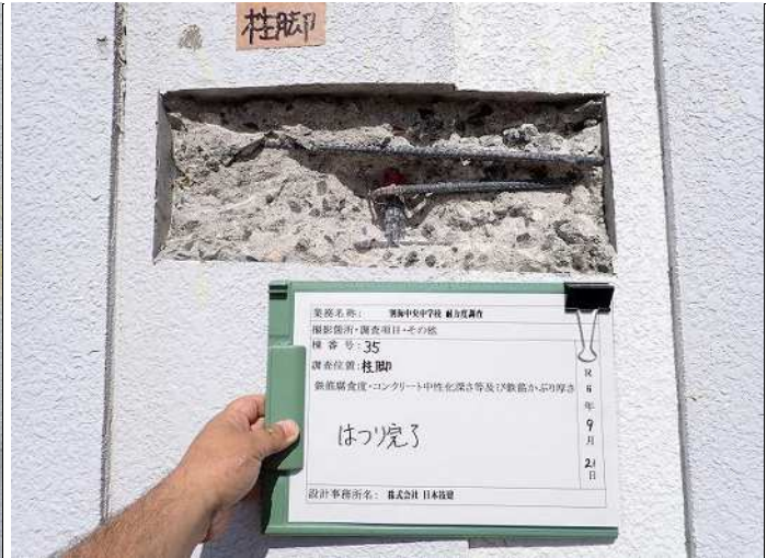
柱脚・柱2 はつり完了 写真番号 14
