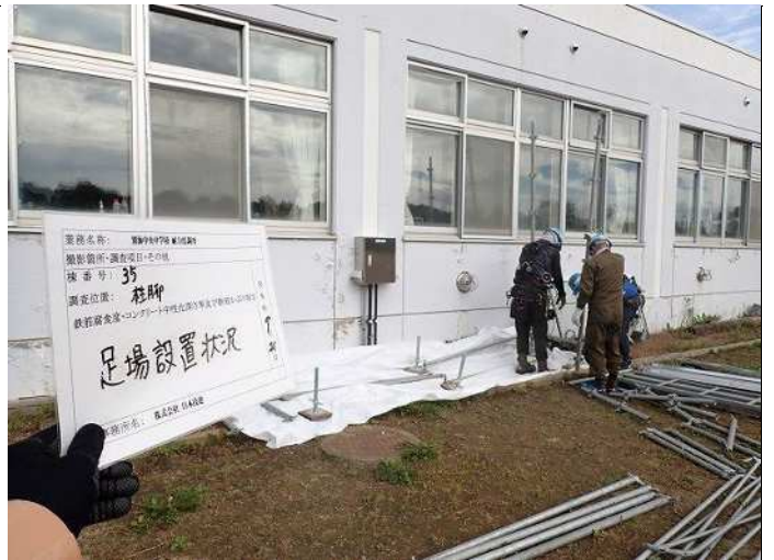
柱頭・柱1,梁1,梁2 足場設置・解体状況 写真番号 49
