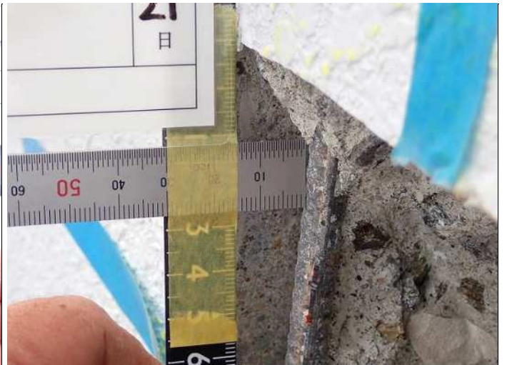
梁2 鉄筋かぶり厚さb 写真番号41詳細(2) 写真番号 43
