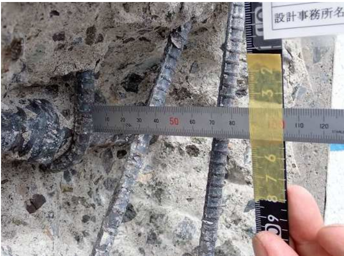
梁1 鉄筋かぶり厚さb 写真番号29詳細(1) 写真番号 30
