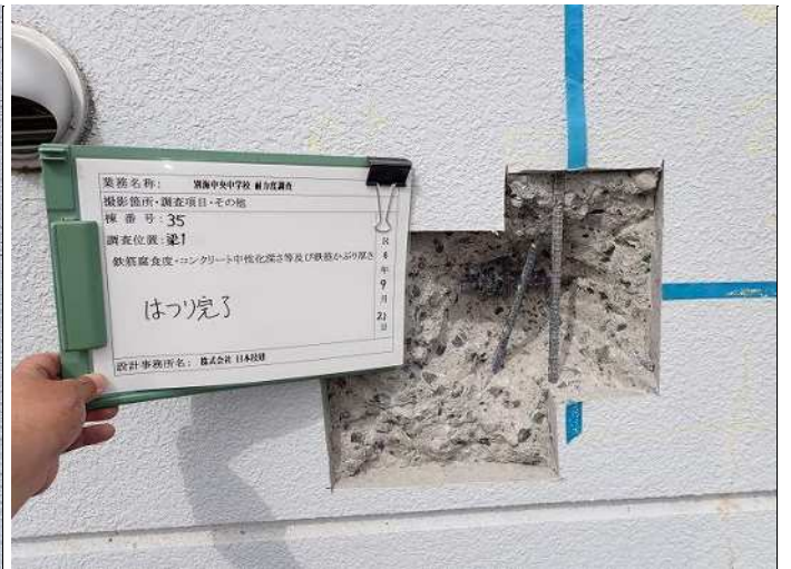
梁1 はつり完了 写真番号 25
