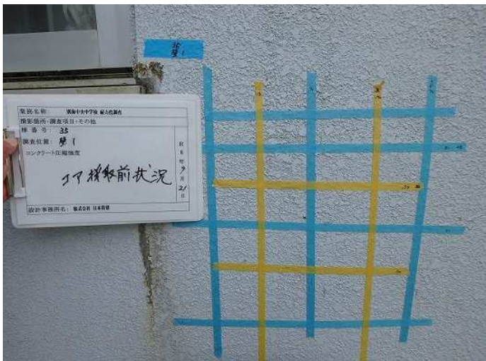
壁1 コンクリート圧縮強度k コア採取前状況 写真番号 1
