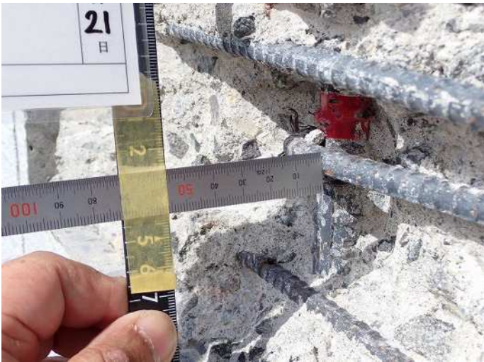
柱脚・柱2 鉄筋かぶり厚さb 写真番号18詳細 写真番号 19
