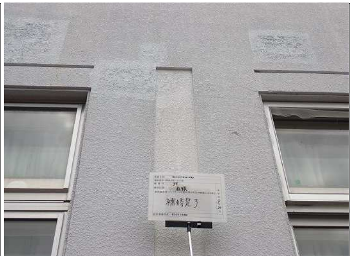
柱頭・柱1 補修完了 写真番号 12
