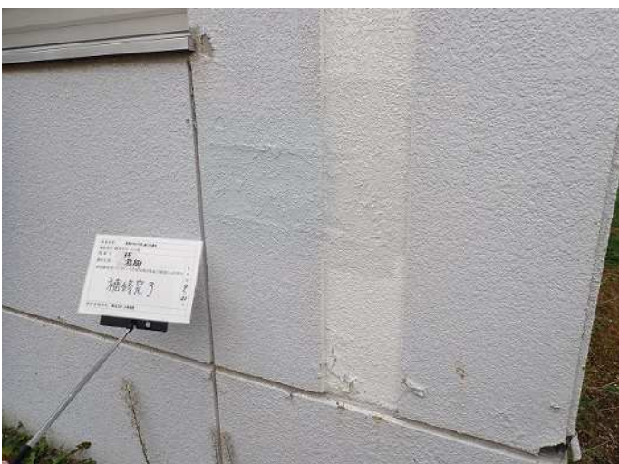
柱脚・柱2 補修完了 写真番号 23
