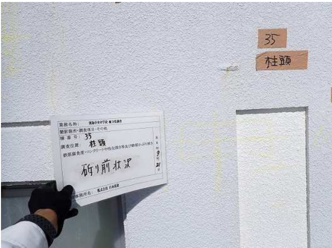
柱頭・柱1 はつり前状況 写真番号 3
