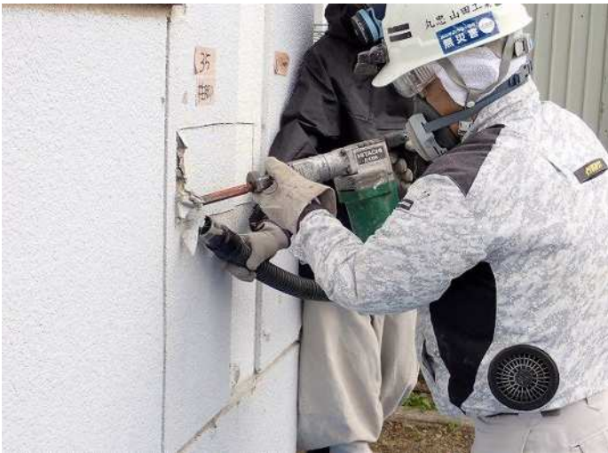
柱脚・柱2 はつり状況 写真番号 48
