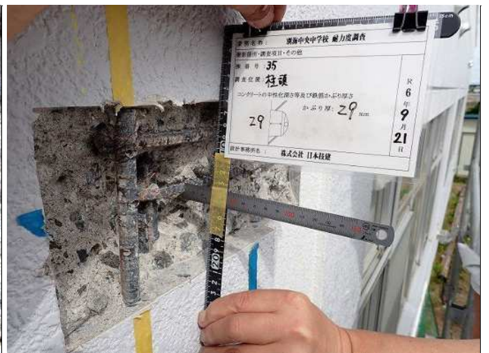
柱頭・柱1 鉄筋かぶり厚さb かぶり厚:2.9cm 写真番号 8
