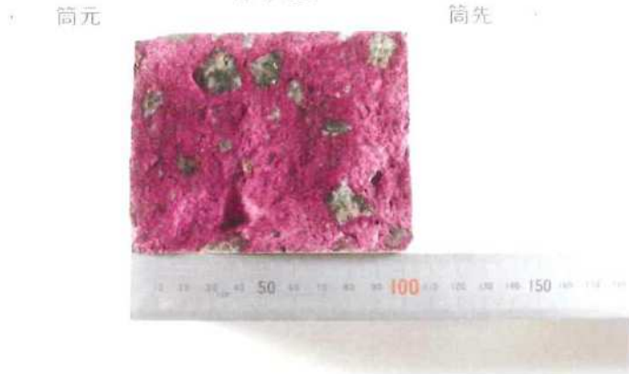
コンクリートの中性化深さ測定(フェノールフタレイン法) 別海中央中学校耐力度調査 別海中央中学校 13-2 壁2
