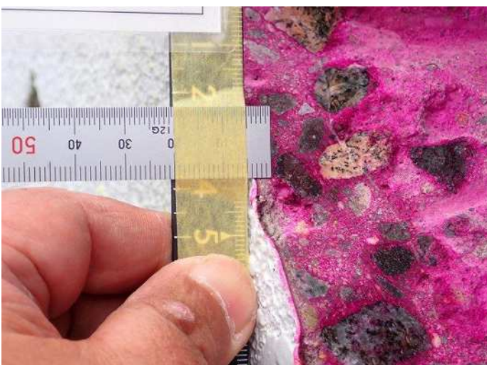
梁2 コンクリート中性化深さa 写真番号44詳細(2) 写真番号 46
