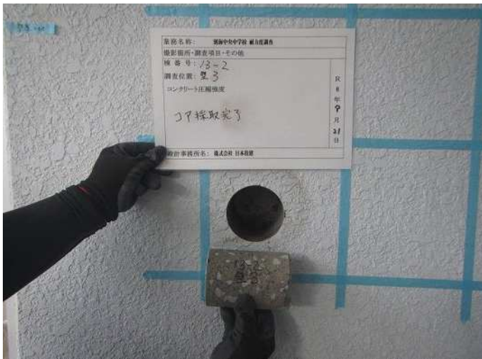
壁3 コンクリート圧縮強度k コア採取完了 写真番号 15
