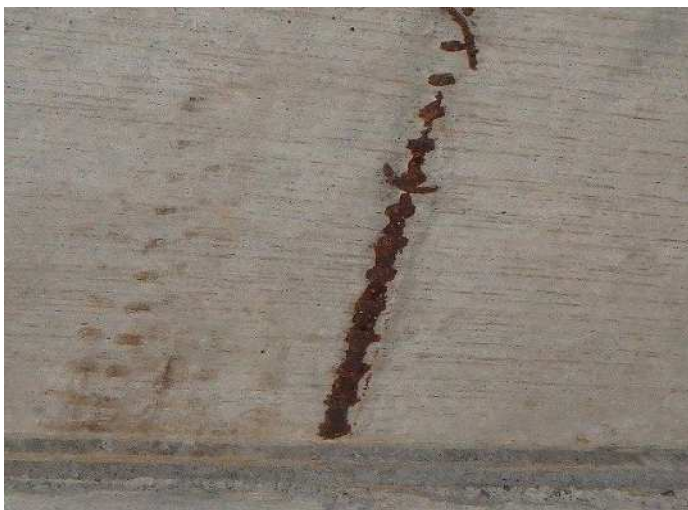
床 鉄筋腐食度F 写真番号1詳細(2) 写真番号 3
