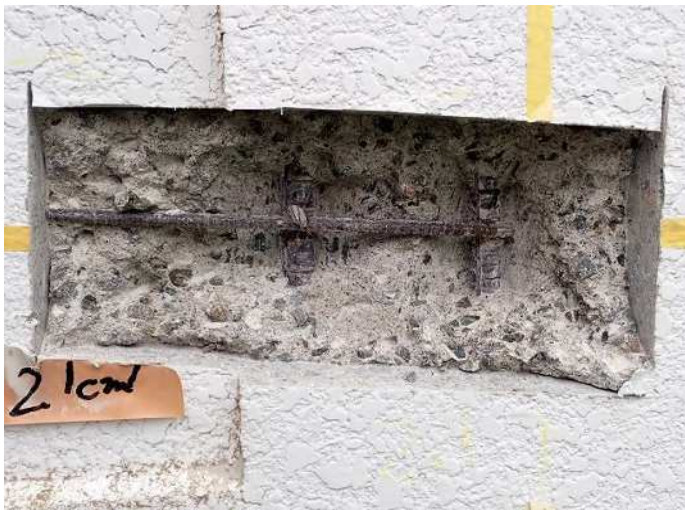
柱脚・柱2 写真番号16詳細 写真番号 17
