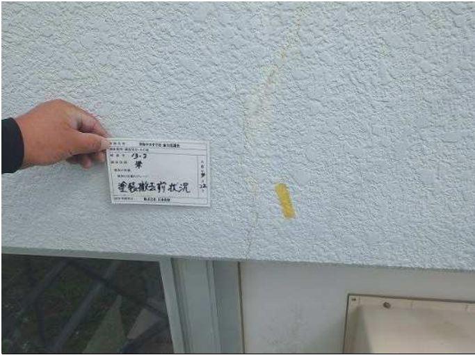
梁 躯体の状態D 塗装撤去前状況 写真番号 3
