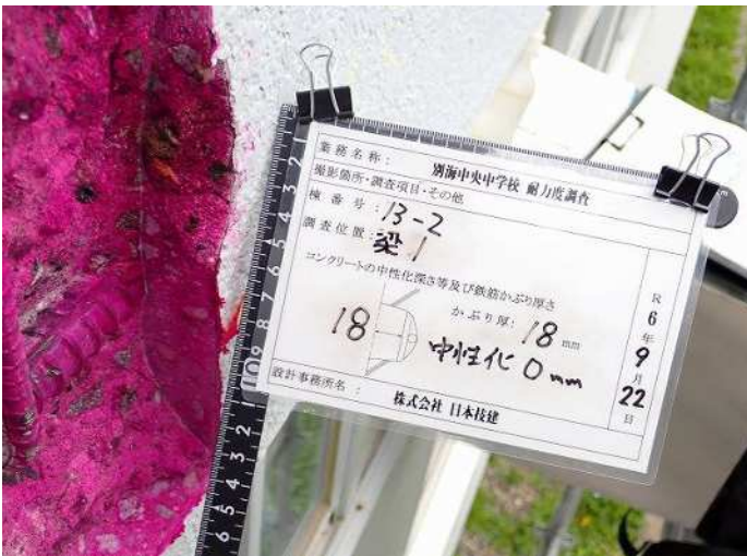
梁1 コンクリート中性化深さa 写真番号33詳細(1) 写真番号 34
