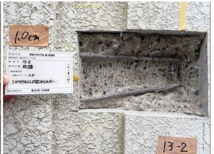
柱頭・柱1 鉄筋腐食度F さびがほとんど認められない(グレード1.0) 写真番号 7
