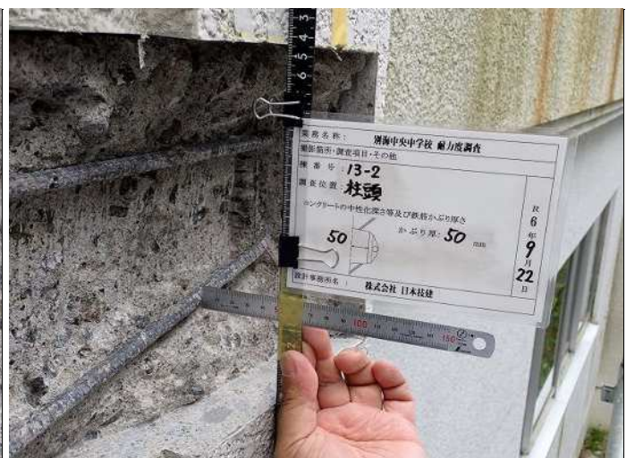
柱頭・柱1 鉄筋かぶり厚さb かぶり厚:5.0cm 写真番号 9
