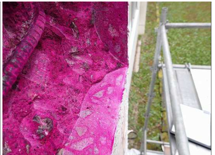
柱頭・柱1 コンクリート中性化深さa 写真番号11詳細(2) 写真番号 13
