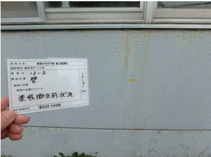
壁 躯体の状態D 塗装撤去前状況 写真番号 7
