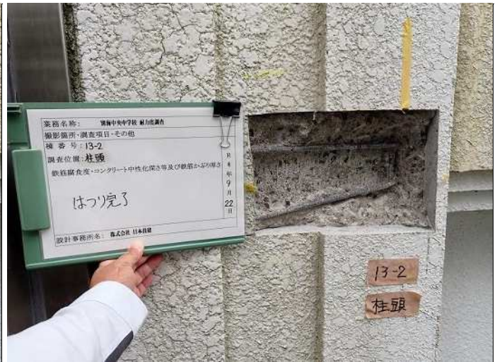
柱頭・柱1 はつり完了 写真番号 5
