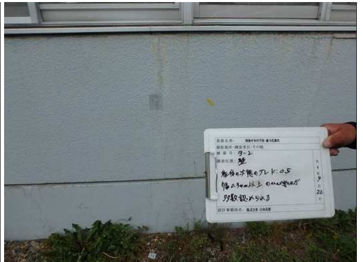
壁 躯体の状態D 幅0.3mm以上のひび割れが多数認められる(グレード0.5) 写真番号 8
