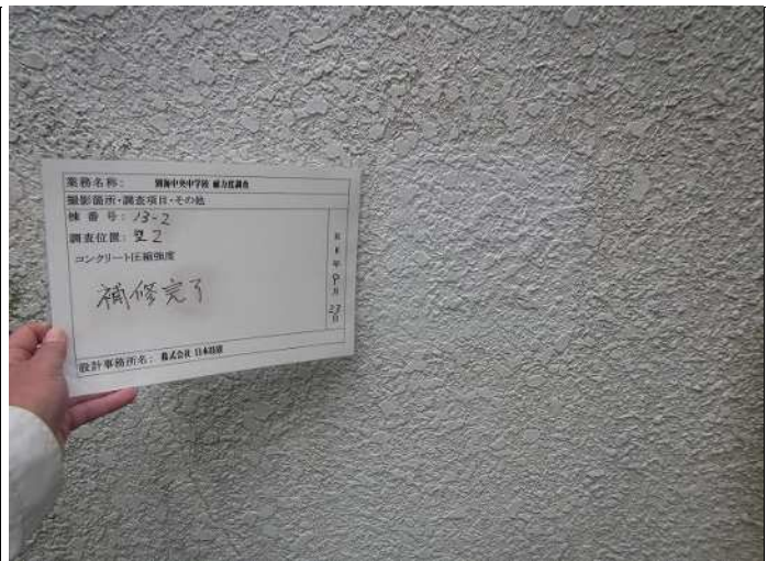
壁2 コンクリート圧縮強度k 補修完了 写真番号 10
