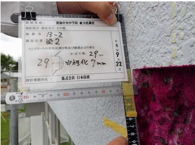
梁2 コンクリート中性化深さa 写真番号44詳細(1) 写真番号 45
