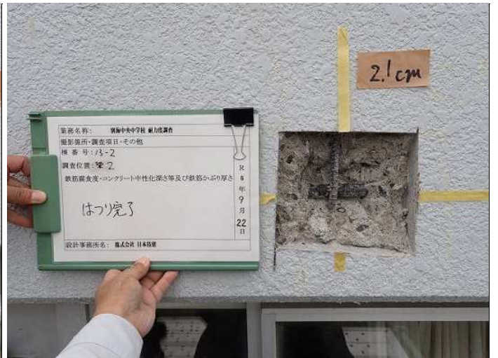
梁2 はつり完了 写真番号 38
