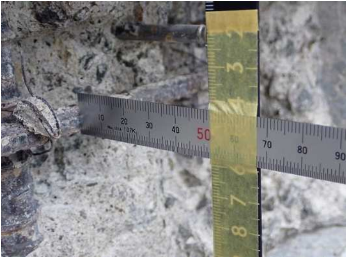
柱脚・柱2 鉄筋かぶり厚さb 写真番号20詳細 写真番号 21
