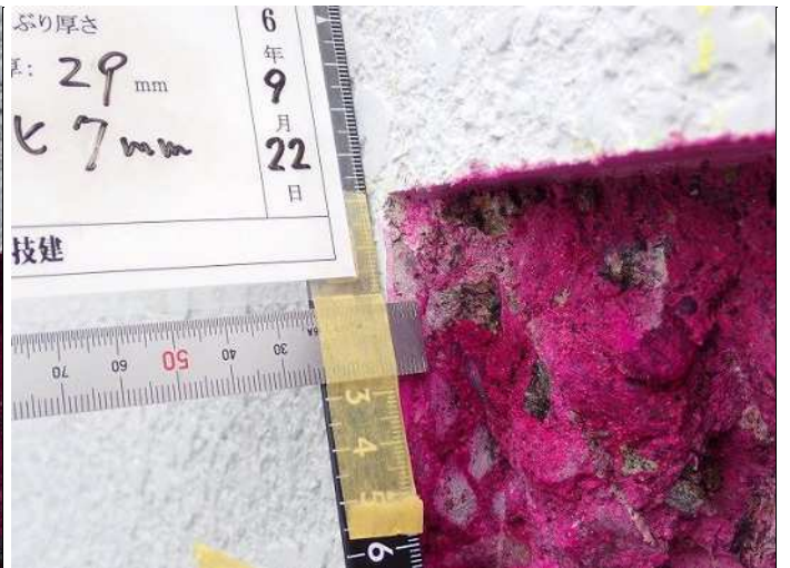
梁2 コンクリート中性化深さa 写真番号44詳細(2) 写真番号 46
