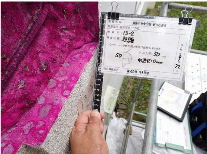
柱頭・柱1 コンクリート中性化深さa 写真番号11詳細(1) 写真番号 12
