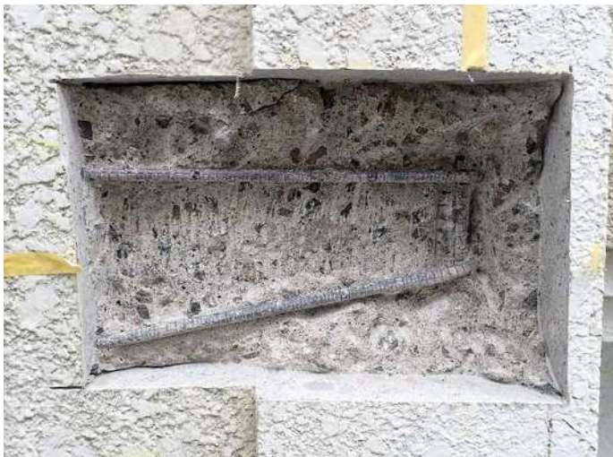
柱頭・柱1 写真番号5詳細 写真番号 6
