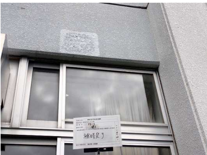
梁2 補修完了 写真番号 47
