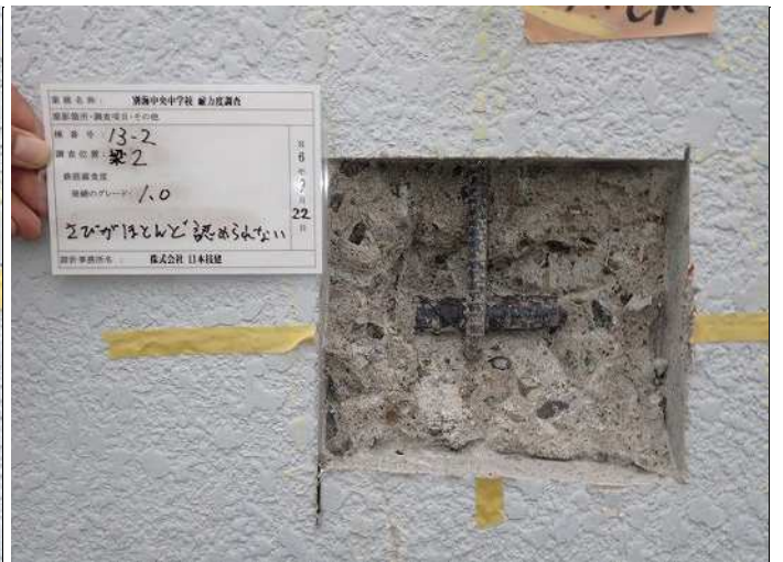
梁2 鉄筋腐食度F さびがほとんど認められない(グレード1.0) 写真番号 40
