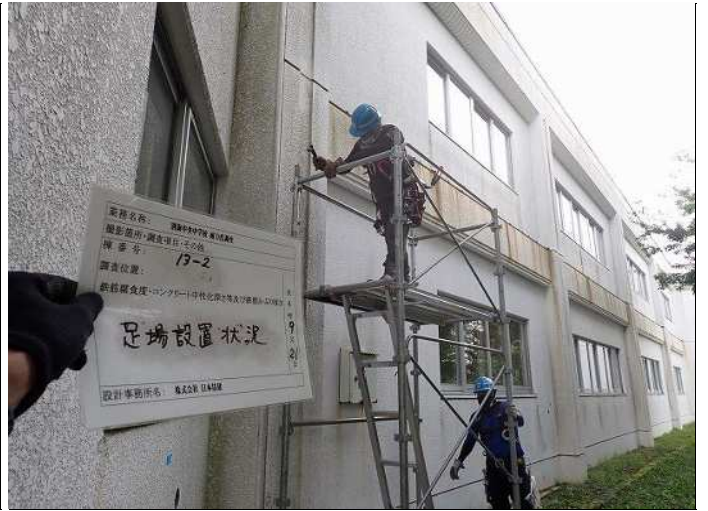
柱頭・柱1 足場設置・解体状況 写真番号 49
