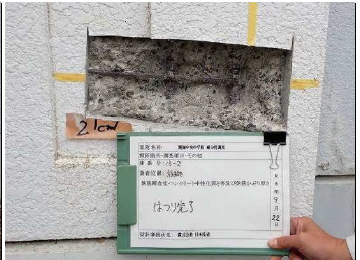
柱脚・柱2 はつり完了 写真番号 16
