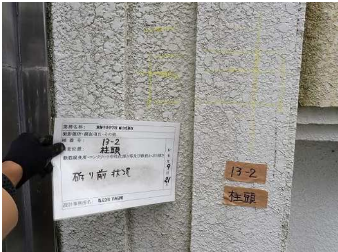
柱頭・柱1 はつり前状況 写真番号 4
