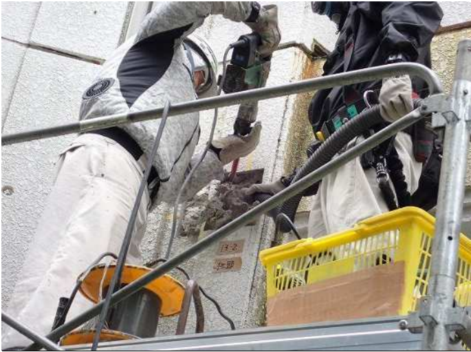
柱頭・柱1 はつり状況 写真番号 48
