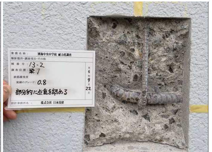
梁1 鉄筋腐食度F 部分的に点食を認める(グレード0.8) 写真番号 29
