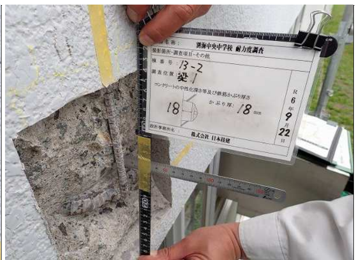
梁1 鉄筋かぶり厚さb かぶり厚:1.8cm 写真番号 31
