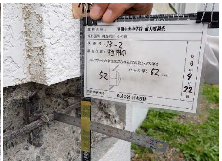
柱脚・柱2 鉄筋かぶり厚さb かぶり厚:5.2cm 写真番号 20
