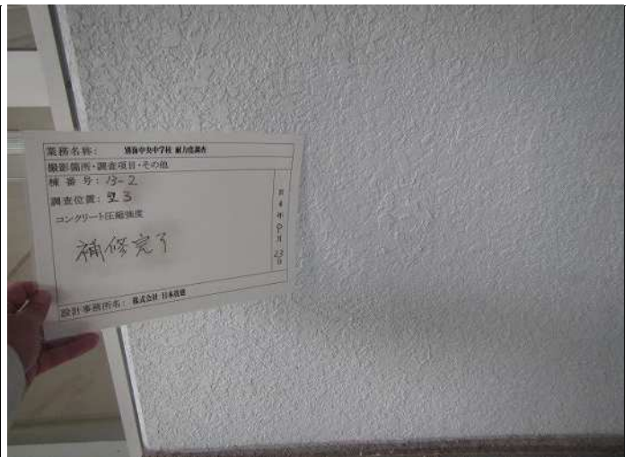
壁3 コンクリート圧縮強度k 補修完了 写真番号 16
