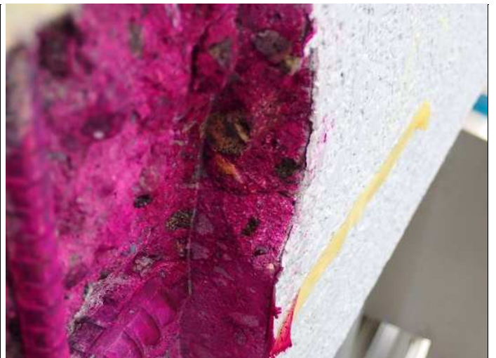
梁1 コンクリート中性化深さa 写真番号33詳細(2) 写真番号 35
