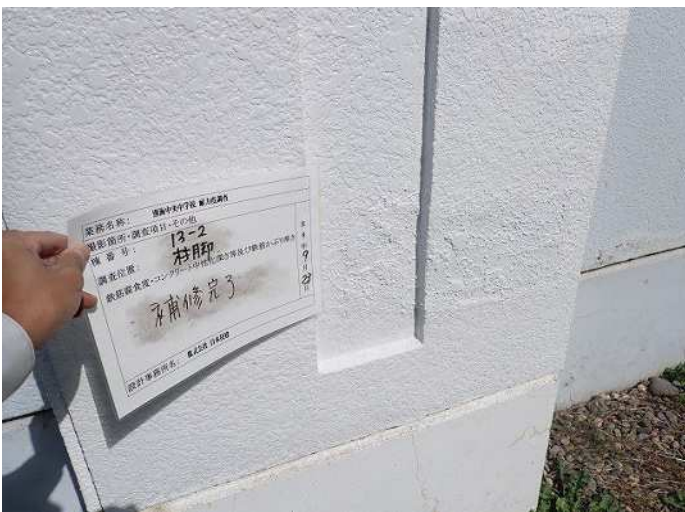
柱脚・柱2 補修完了 写真番号 25
