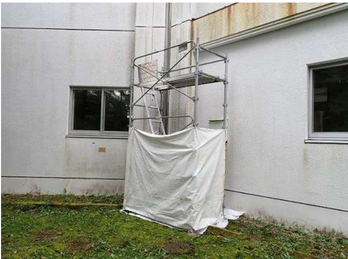
柱頭・柱1 足場設置完了 写真番号 50
