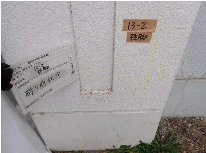
柱脚・柱2 はつり前状況 写真番号 15
