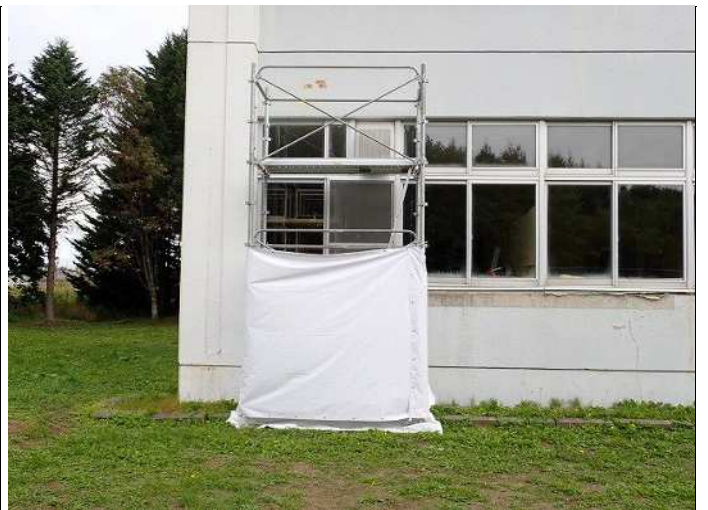
梁1 足場設置完了 写真番号 51
