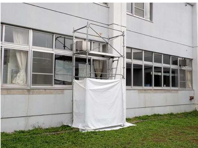
梁2 足場設置完了 写真番号 52
