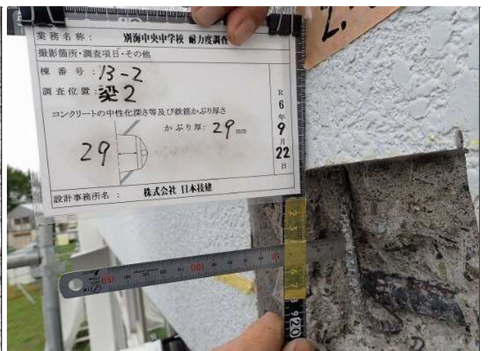
梁2 鉄筋かぶり厚さb かぶり厚:2.9cm 写真番号 42
