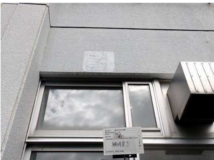
梁1 補修完了 写真番号 36
