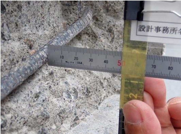
柱頭・柱1 鉄筋かぶり厚さb 写真番号9詳細 写真番号 10
