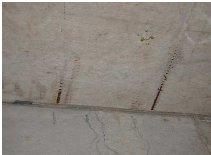
床 鉄筋腐食度F 写真番号1詳細(1) 写真番号 2
