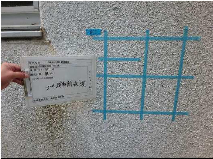
壁2 コンクリート圧縮強度k コア採取前状況 写真番号 7
