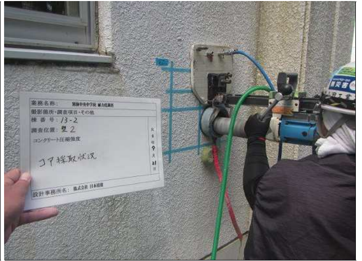
壁2 コンクリート圧縮強度k コア採取状況 写真番号 8
