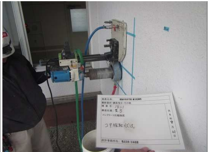
壁3 コンクリート圧縮強度k コア採取状況 写真番号 14
