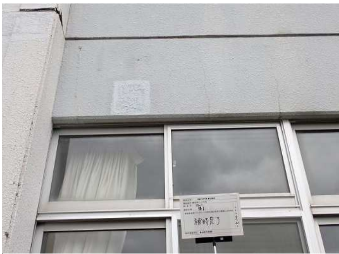
梁1 補修完了 写真番号 35
