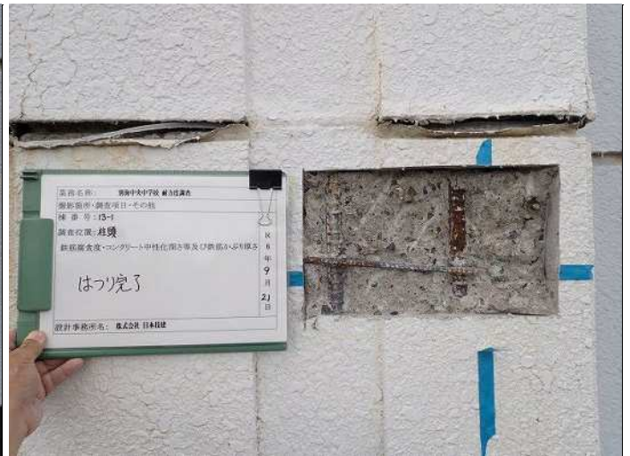
柱頭・柱1 はつり完了 写真番号 4
