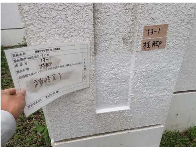
柱脚・柱2 補修完了 写真番号 24
