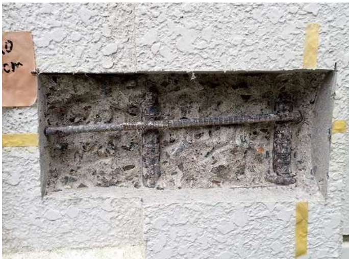
柱脚・柱2 写真番号15詳細 写真番号 16
