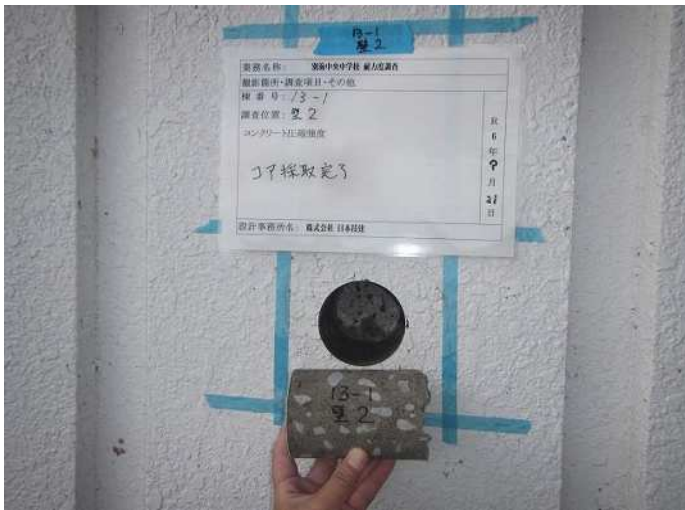
壁2 コンクリート圧縮強度k コア採取完了 写真番号 9
