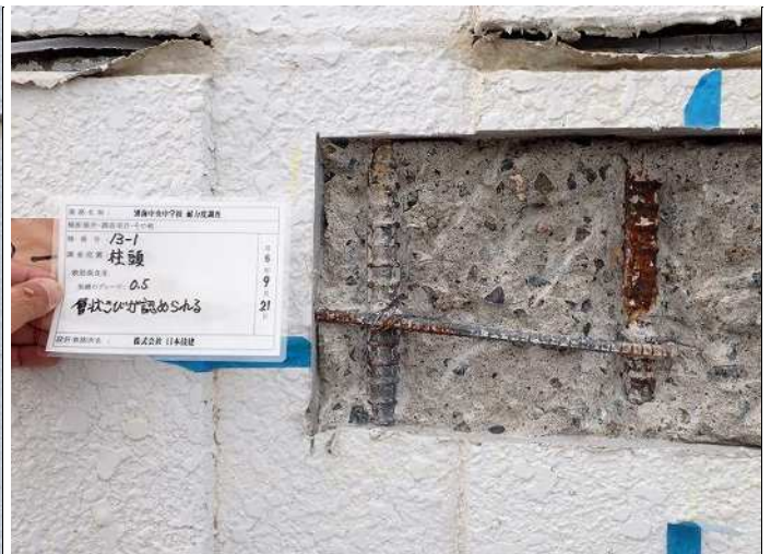
柱頭・柱1 鉄筋腐食度F 層状さびが認められる(グレード0.5) 写真番号 6
