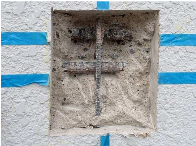
梁2 写真番号37詳細 写真番号 38
