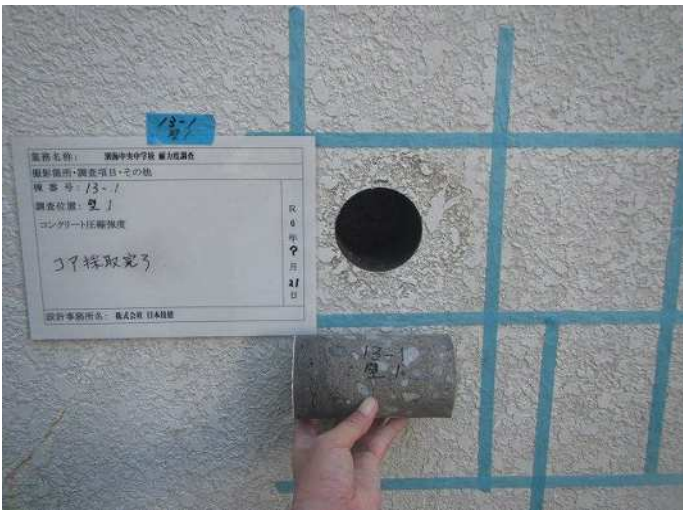
壁1 コンクリート圧縮強度k コア採取完了 写真番号 3
