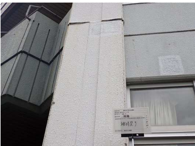
柱頭・柱1 補修完了 写真番号 13
