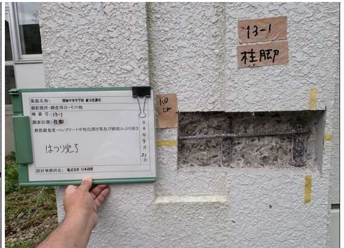
柱脚・柱2 はつり完了 写真番号 15
