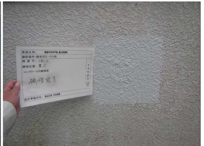
壁1 コンクリート圧縮強度k 補修完了 写真番号 4
