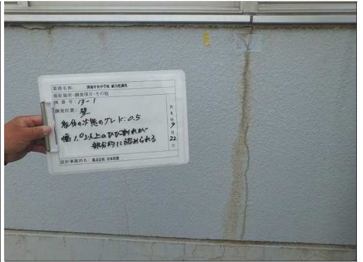
壁 躯体の状態D 幅1.0mm以上のひび割れが部分的に認められる(グレード0.5) 写真番号 8
