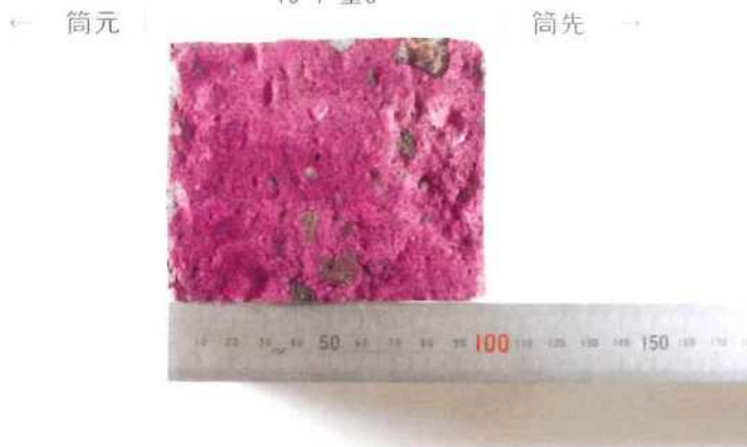
コンクリートの中性化深さ測定(フェノールフタレイン法) 別海中央中学校耐力度調査 別海中央中学校 13-1 壁3
