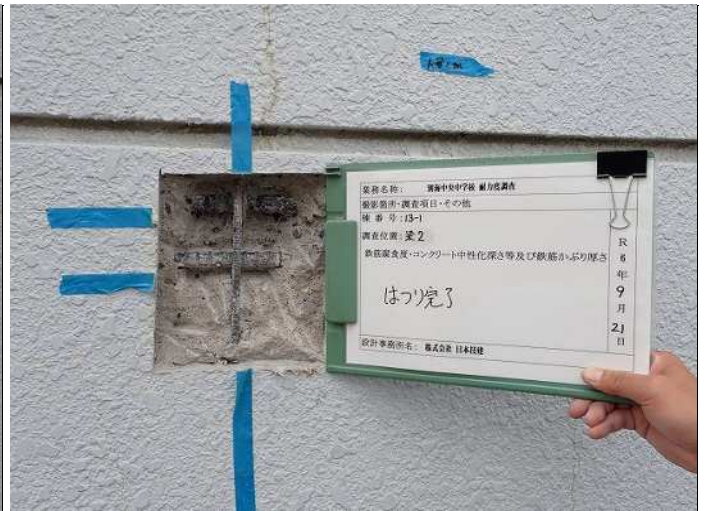
梁2 はつり完了 写真番号 37
