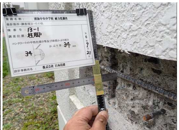
柱脚・柱2 鉄筋かぶり厚さb かぶり厚:3.4cm 写真番号 19
