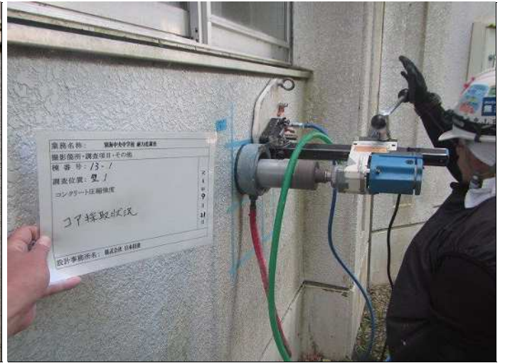
壁1 コンクリート圧縮強度k コア採取状況 写真番号 2
