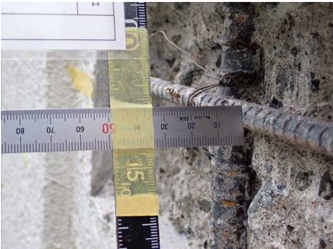
柱脚・柱2 鉄筋かぶり厚さb 写真番号19詳細 写真番号 20
