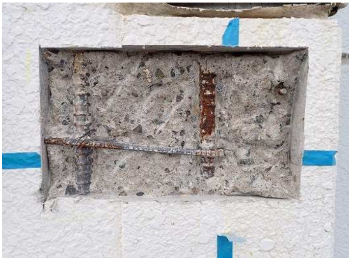
柱頭・柱1 写真番号4詳細 写真番号 5
