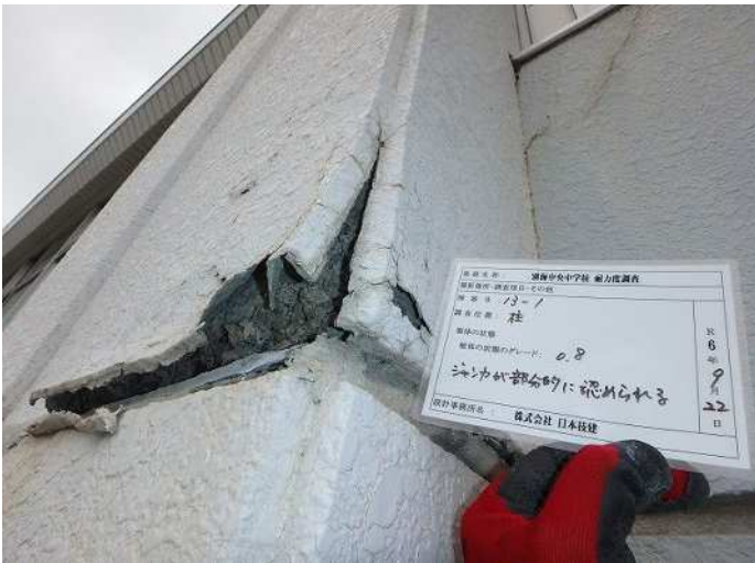
柱 躯体の状態D ジャンカが部分的に認められる(グレード0.8) 写真番号 1
