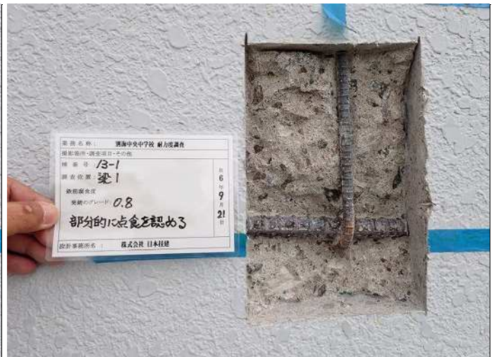
梁1 鉄筋腐食度F 部分的に点食を認める(グレード0.8) 写真番号 28
