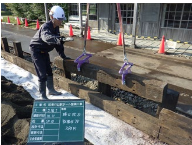
横木枕木設置状況（10月31日）
