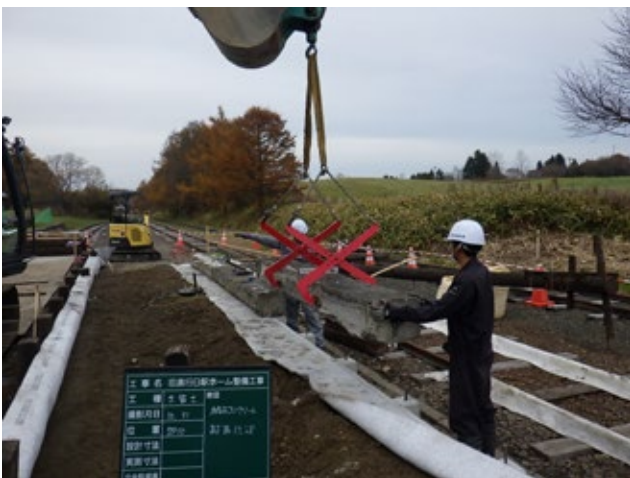
縁石コンクリート設置状況（10月31日）
