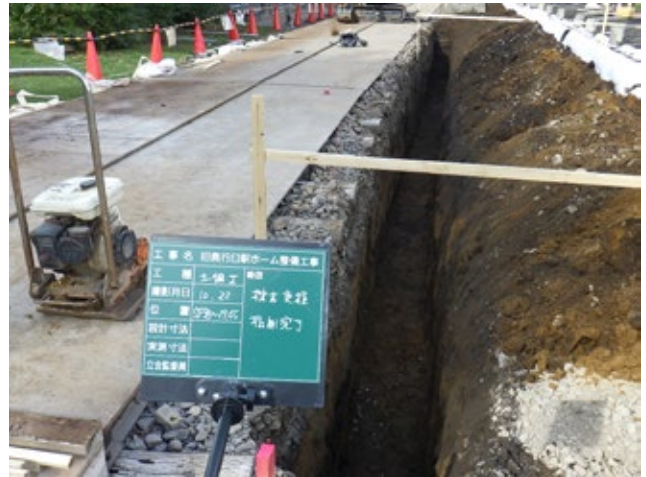
枕木支柱掘削完了（10月22日）
