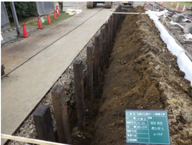
枕木支柱建込完了（10月23日）
