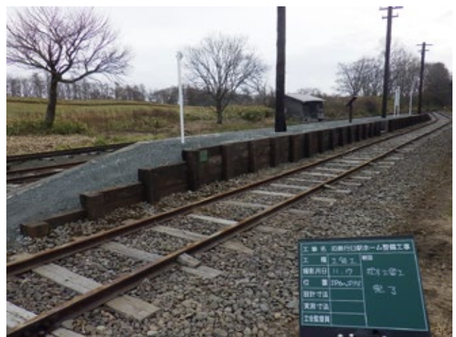
枕木土留工完了（11月17日）
