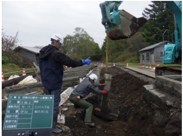
コンクリート支柱撤去状況（10月11日）
