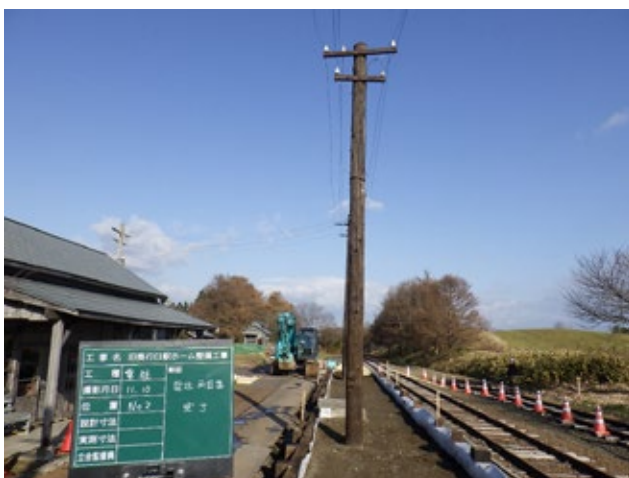
電柱再設置完了（11月10日）
