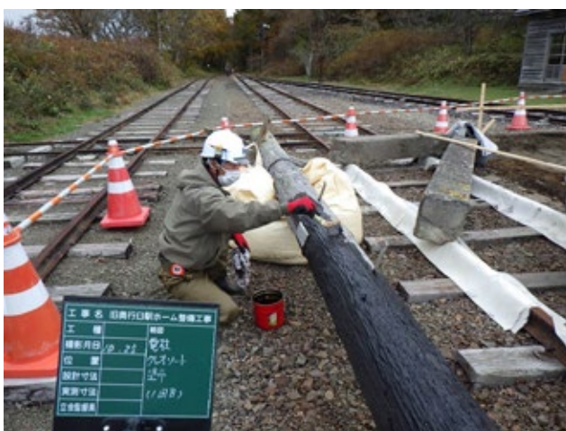
電柱クレオソート塗布（10月25日）
