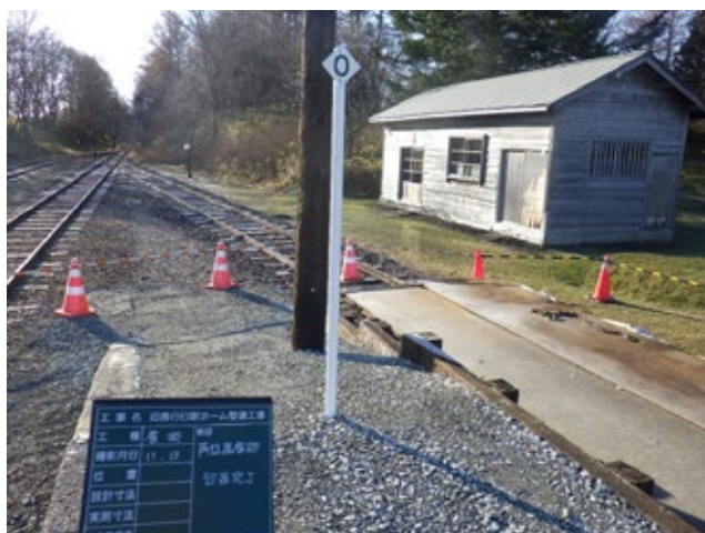
停止位置目標設置完了（11月13日）
