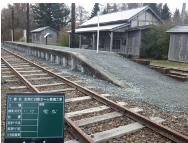
ホーム工事完成（11月17日）
