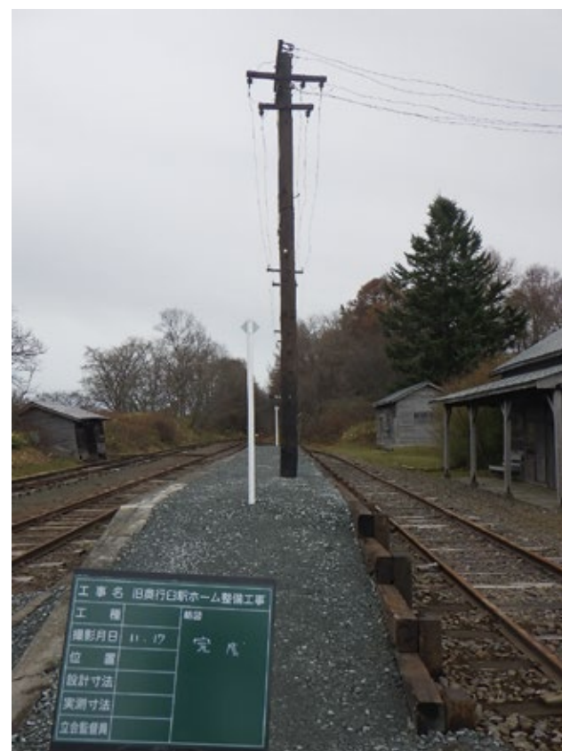
ホーム工事完成（11月17日）
