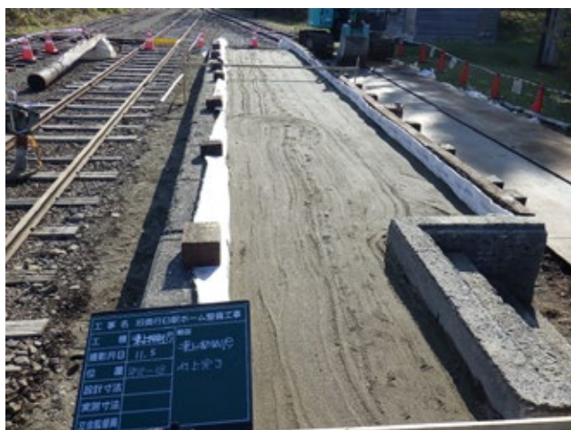
凍上抑制層仕上完了（11月5日）
