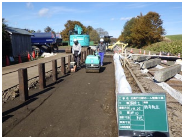
路床転圧（10月25日）
