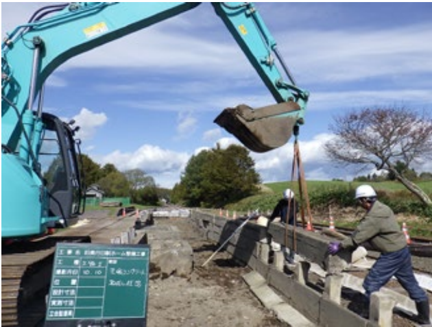
天端コンクリート（縁石）取り外し状況（10月10日）
