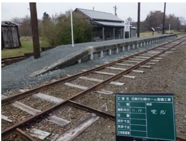
ホーム工事完成（11月17日）
