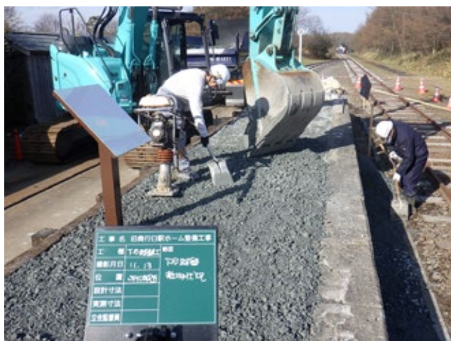
下層路盤敷均状況（11月13日）
