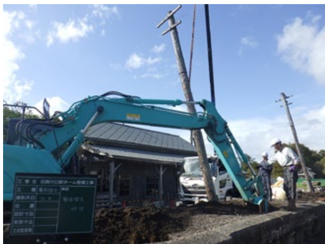
電柱撤去状況（10月8日）
