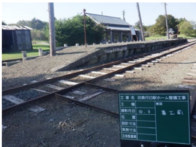
ホーム工事着工前（10月3日）
