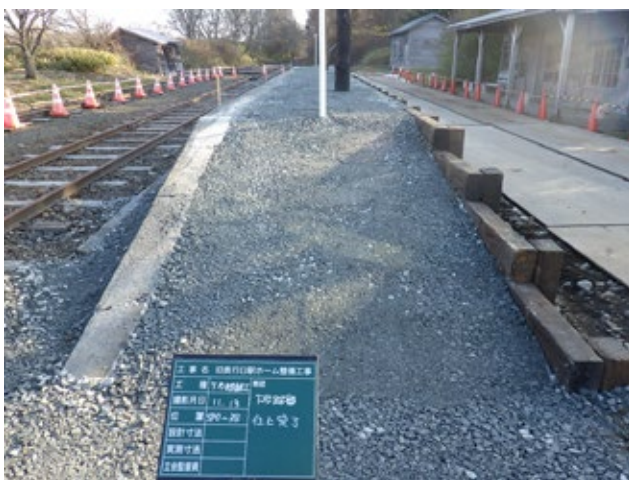
下層路盤仕上完了（11月13日）
