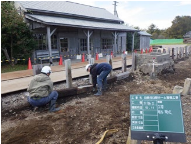
土留枕木撤去（10月11日）
