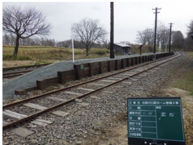
ホーム工事完成（11月17日）
