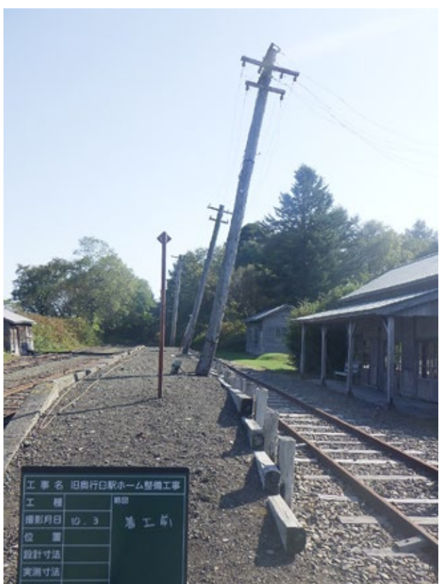
ホーム工事着工前（10月3日）
