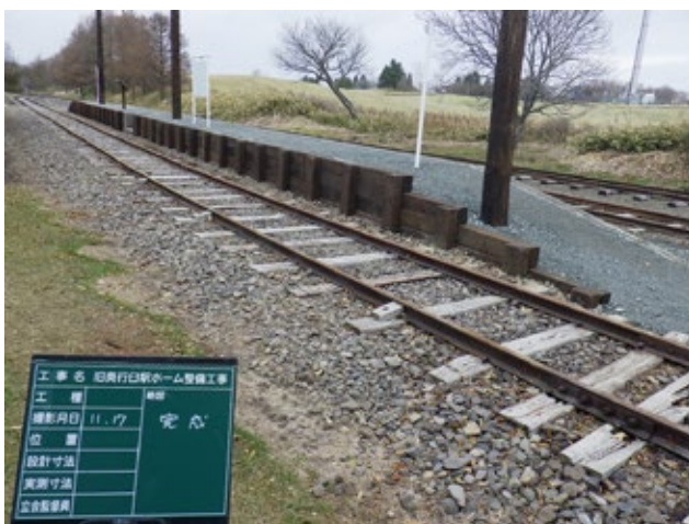
ホーム工事完成（11月17日）
