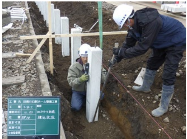
コンクリート支柱建込状況（10月20日）
