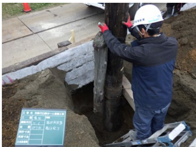
電柱再設置建込完了（11月6日）
