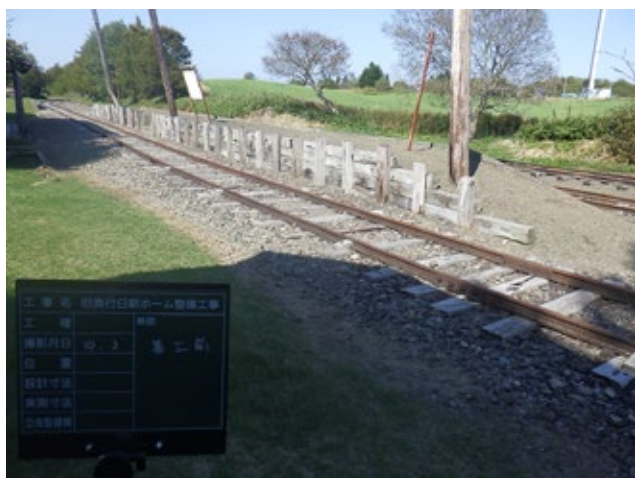
ホーム工事着工前（10月3日）
