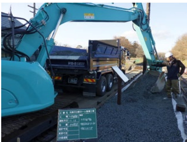
下層路盤切込砂利搬入状況（11月12日）
