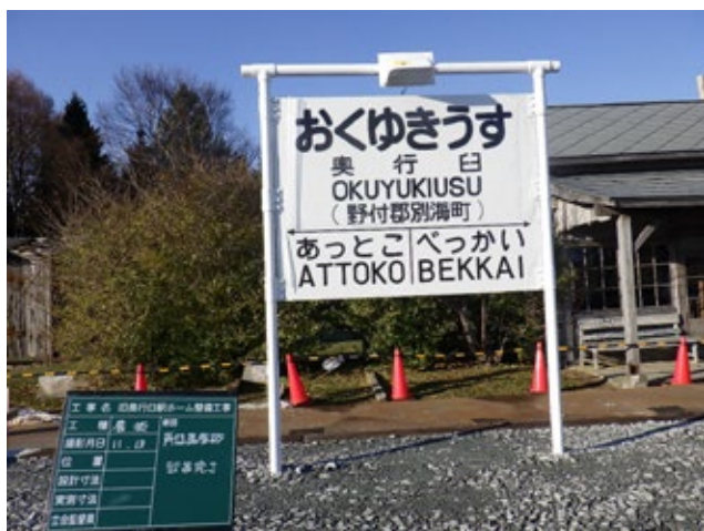
駅名標設置完了（11月13日）
