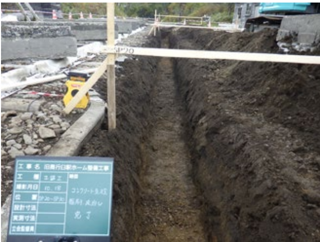
コンクリート支柱掘削・床均し完了（10月18日）
