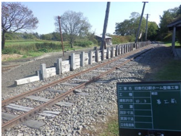
ホーム工事着工前（10月3日）
