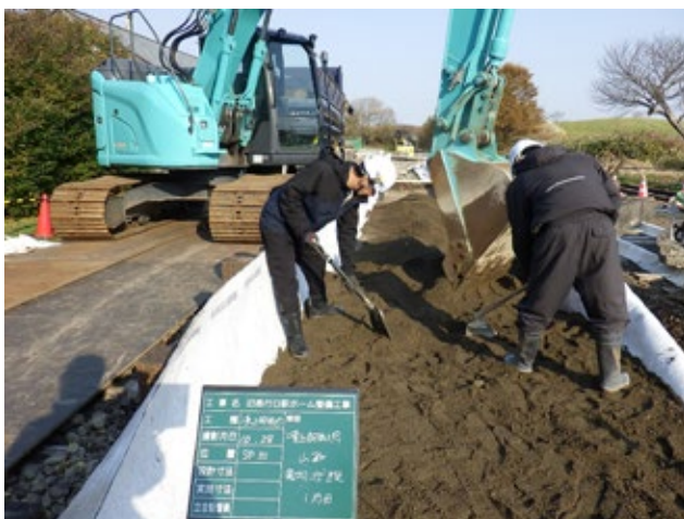
凍上抑制層山砂敷均状況（10月28日）
