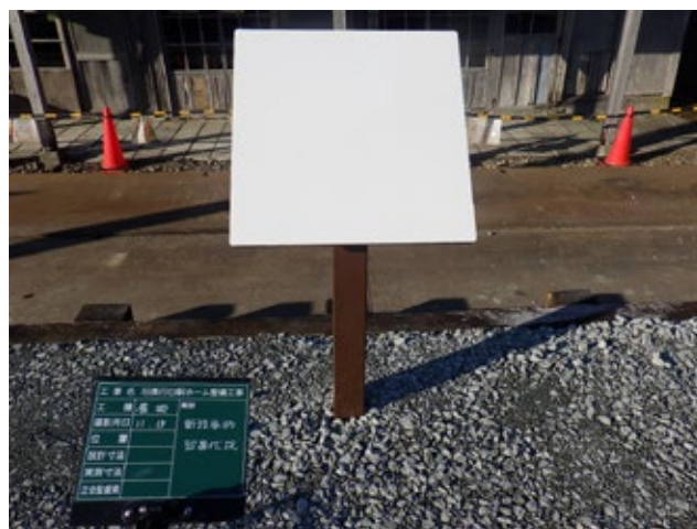
寄附者芳名板設置完了（11月13日）
