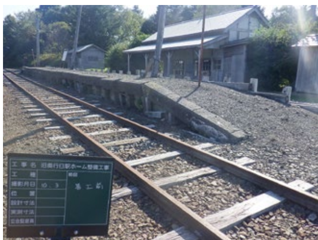
ホーム工事着工前（10月3日）
