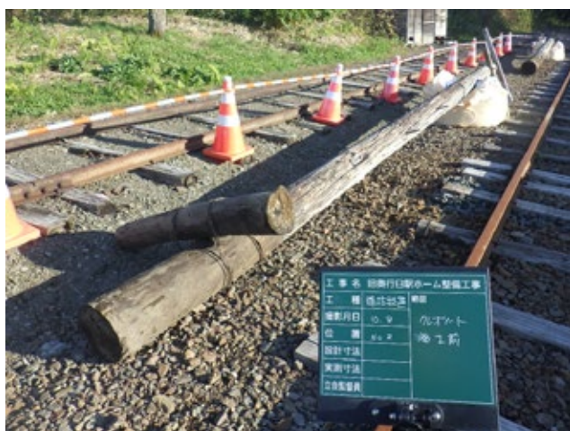
撤去した電柱（10月8日）
