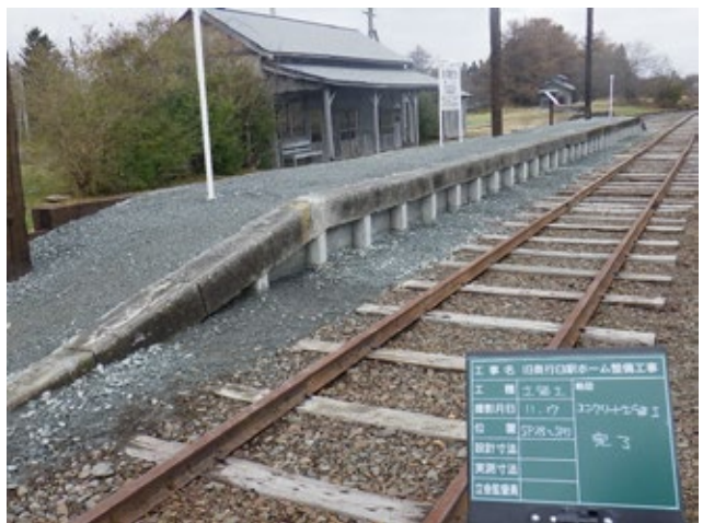
コンクリート土留工完了（11月17日）
