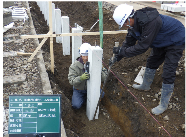
コンクリート支柱建込状況（10月20日）
