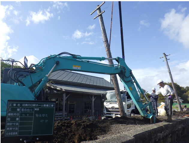
電柱撤去状況（10月8日）
