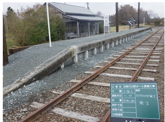
コンクリート土留工完了（11月17日）
