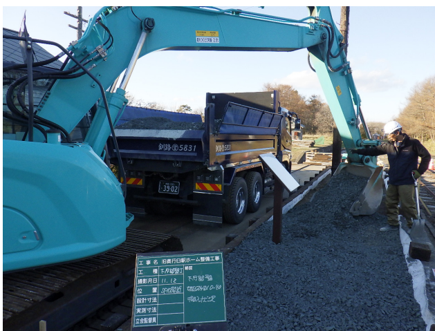
下層路盤切込砂利搬入状況（11月12日）
