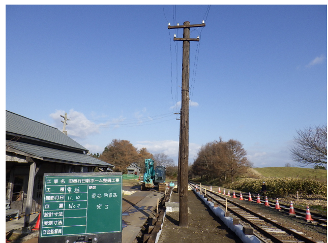
電柱再設置完了（11月10日）
