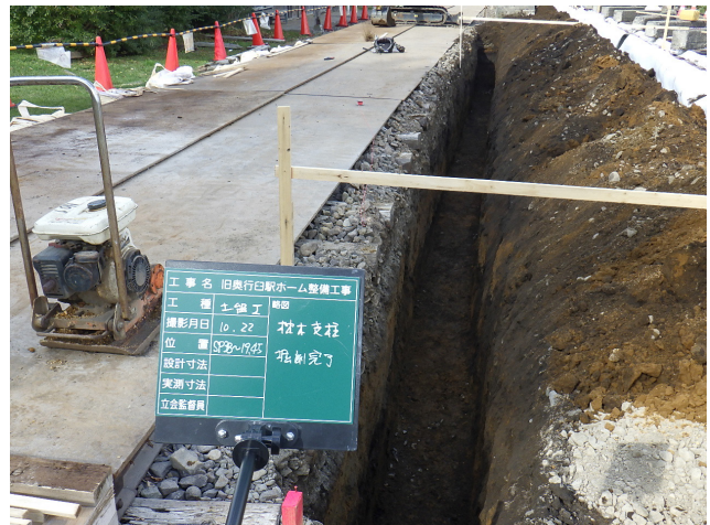
枕木支柱掘削完了（10月22日）
