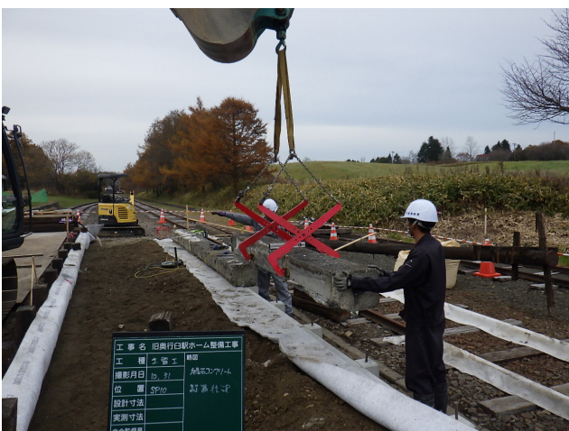
縁石コンクリート設置状況（10月31日）
