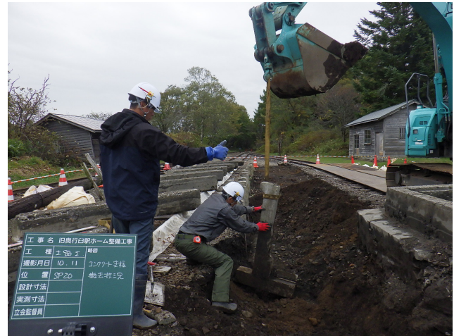
コンクリート支柱撤去状況（10月11日）
