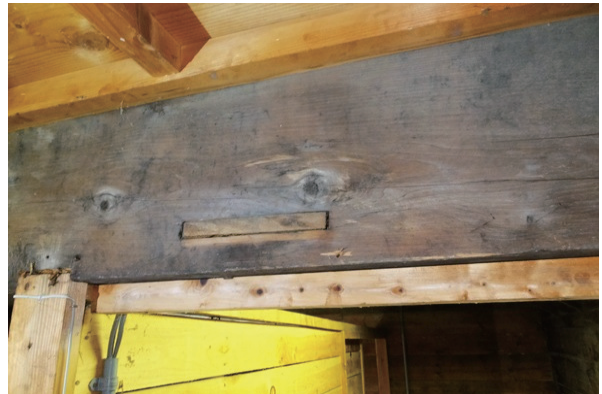
図 24 陸梁に残る火打梁の痕跡
