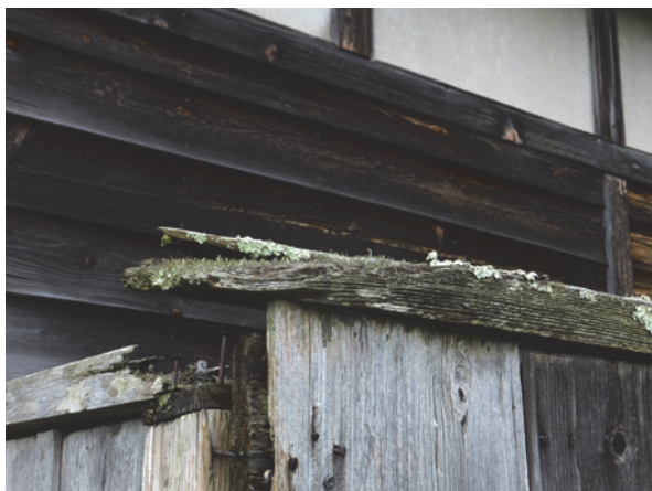
図 33 便所の板塀に見る木部の破損・腐朽状況
