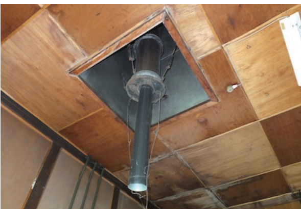
図 22 事務室天井中央にある煙突用の開口部
