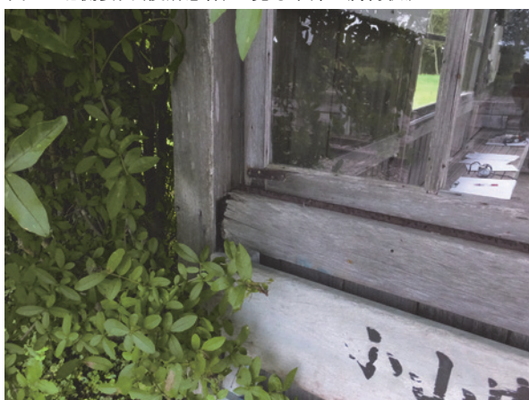
図 31 待合室窓枠の破損状況(ホーム側)
