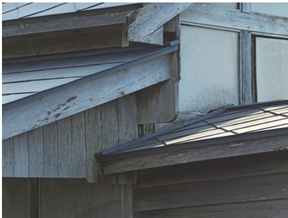
図 35 屋根葺き材と木部との接合部における腐朽状況
