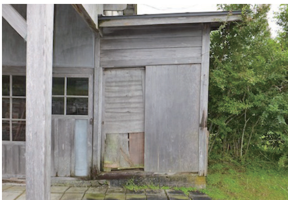
図27 保管室の基礎の傾き具合と扉の破損状況
