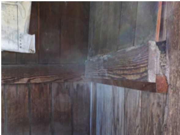
図 39 待合室南西隅に見る部材の浮き具合
