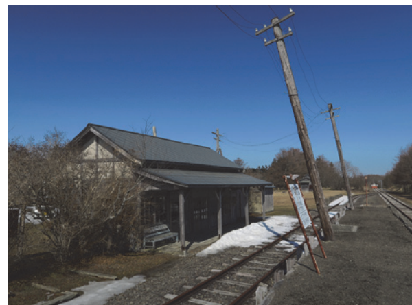
図 44 電柱の傾き具合（ホームの南側から見る）
