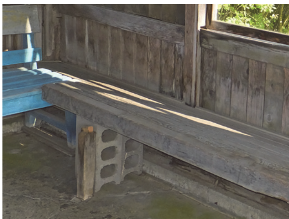
図 41 待合室腰掛けの破損状況
