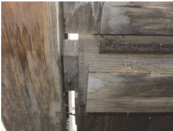
図 37 待合室ホーム側(東側)の窓枠にみる軸部の抜け具合
