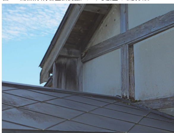
図 32 妻壁(北側)の破損状況
