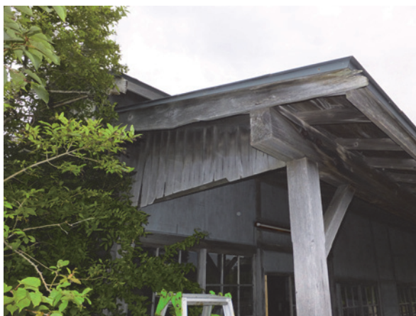
図 34 ホーム側の庇(南側)に見る破風板の欠損状況
