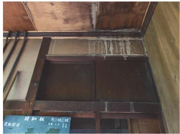
図 42 事務室戸棚上部に見る雨漏りの跡
