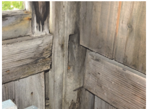
図 38 待合室南東隅に見る軸部の破損、抜け具合
