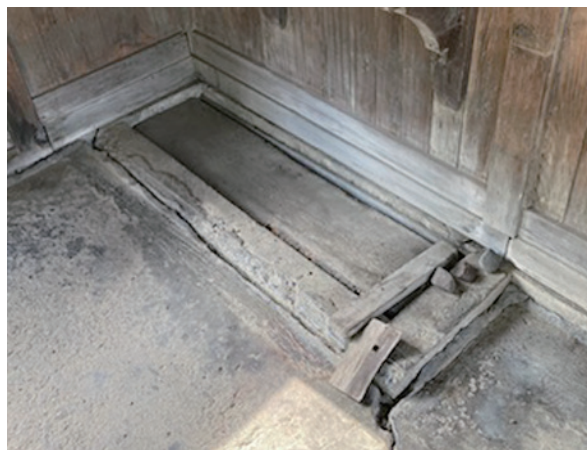
図 17 出札口カウンター直下のコンクリート枠と蓋
