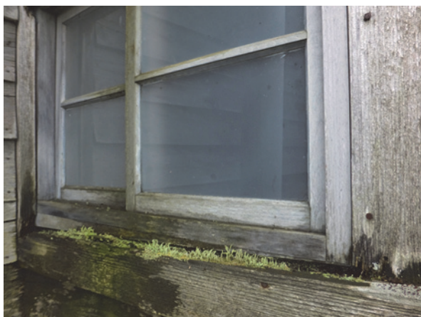
図 29 北側妻面(便所窓枠)に見る木部の腐朽状況
