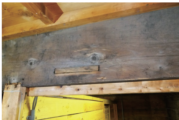
図 24 陸梁に残る火打梁の痕跡
