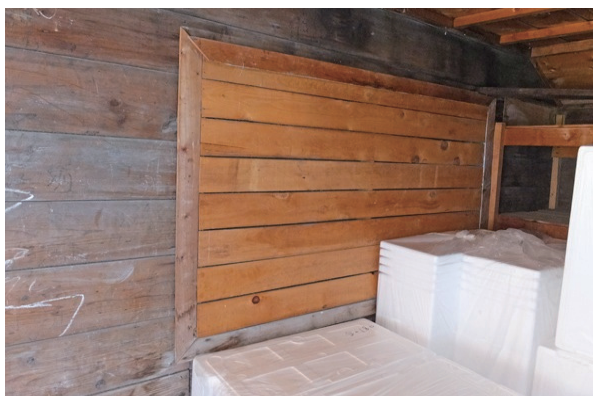
図 21 南妻面に残る中学校々舎時代の窓枠
