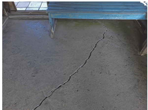
図 36 待合室土間コンクリートの亀裂
