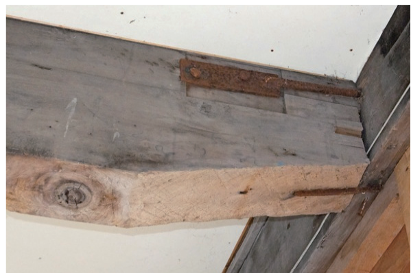
図 18 搬出入口の高さに合わせて削がれた桁端部
