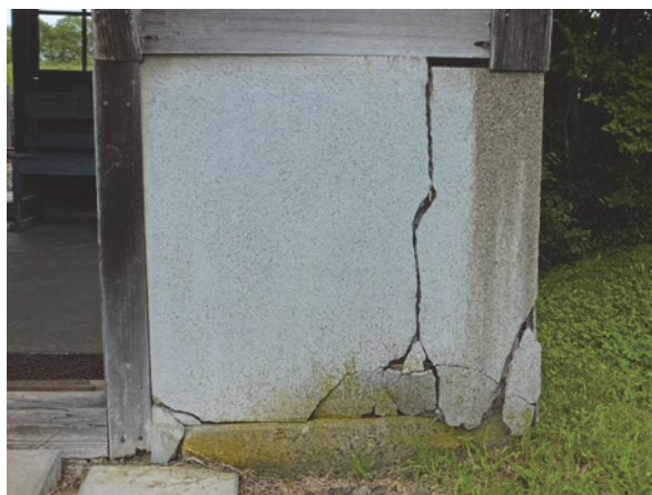
図 30 南西隅(待合室玄関脇)にみる腰壁の破損状況
