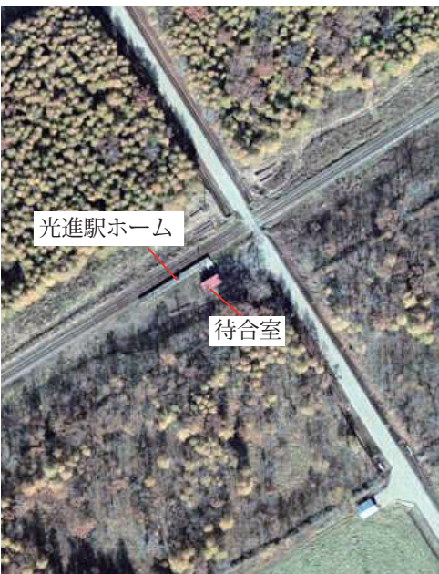
図2 光進駅航空写真(1978年)
