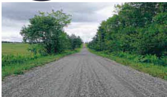
未舗装道路の改良工事
