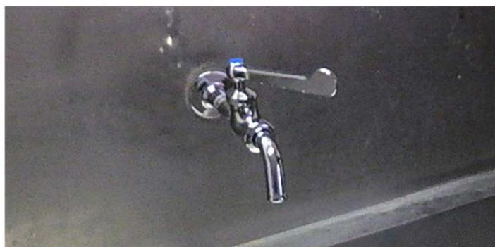
新型コロナウイルス感染症対策として、全小・中学校及び幼稚園の水栓取替工事を実施した。（レバー式へ取替）
