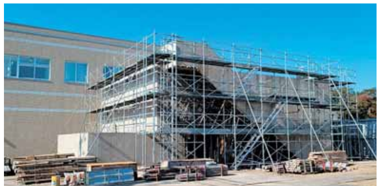
MR I棟の建設工事模様
