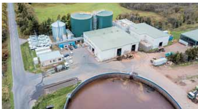
中春別・平糸地区にある(株)別海バイオガス発電の施設
