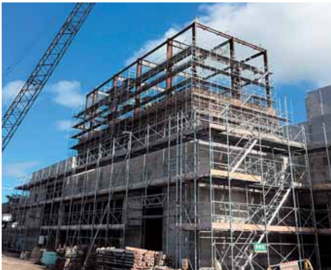
建設中の生涯学習センター
