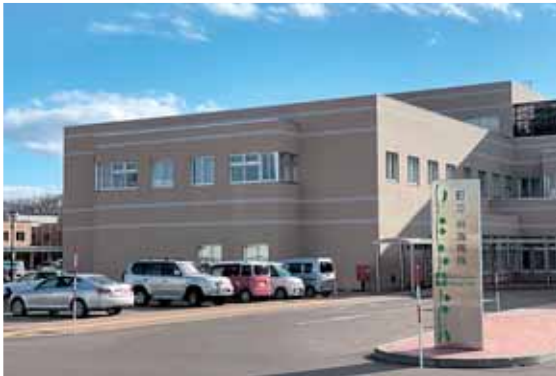
MRI設備が増築される予定の箇所
