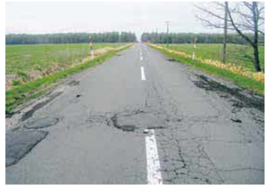
舗装修繕工事
