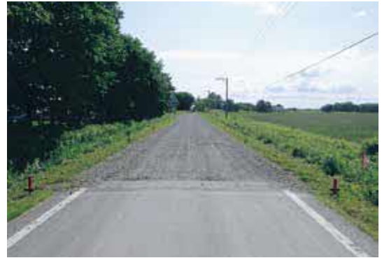
未舗装道路の改良舗装工事
