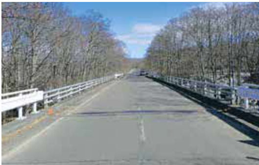
橋梁の補修工事
