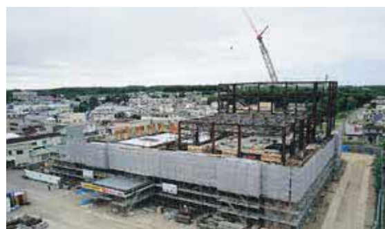
工事中の生涯学習センター
