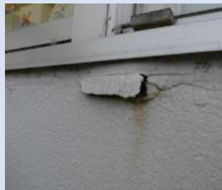
サッシ下部充填モルタル隔離
