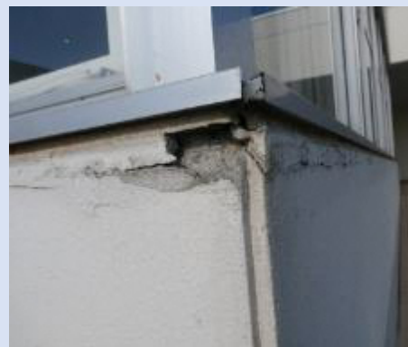
サッシ下部充填モルタル隔離
