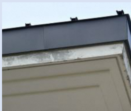
屋根(軒)周辺の状況
