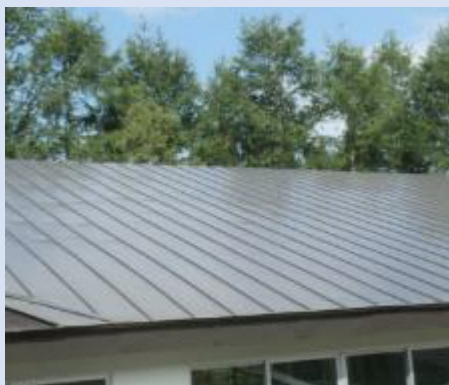
屋根(改修済み)
