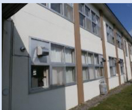
外壁(改修済み)
