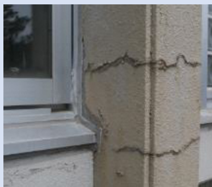
外壁(柱)亀裂
