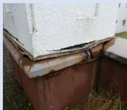
コンクリート柱下部(2F屋上)
