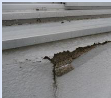
サッシ下部充填モルタル隔離
