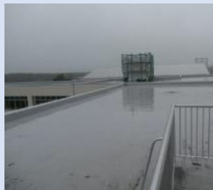
屋上防水(改修済み)
