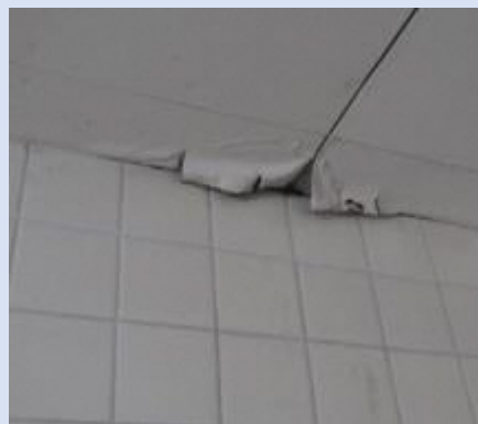
内装(トイレ天井)
