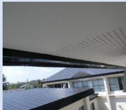
近年改修された屋根・軒天
