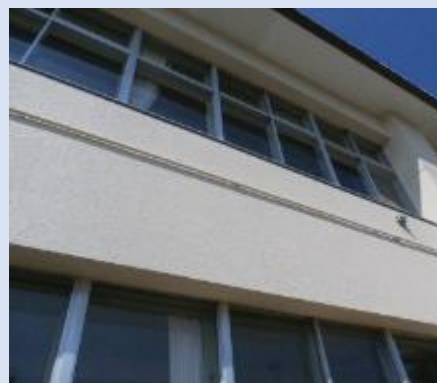
近年改修された外壁
