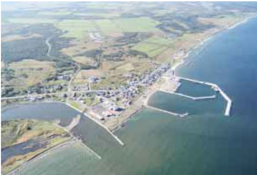
建設が進む別海漁港新港
