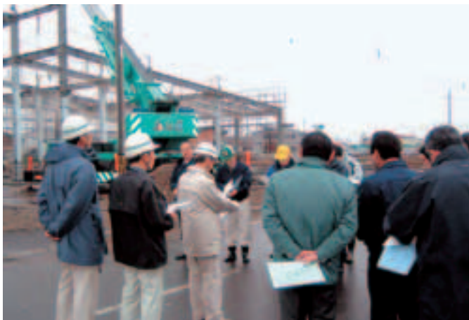
順調に工事が進んでいる本別海の水産物鮮度保持施設
