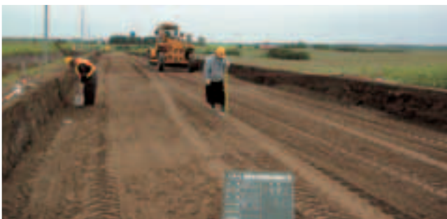
西春別中西別線改良舗装工事
