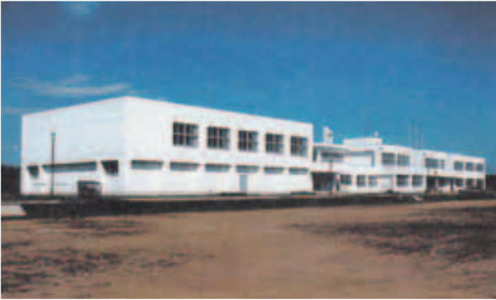
防音事業のため転用に制限があり跡地利用が遅れた旧光進小中学校校舎
