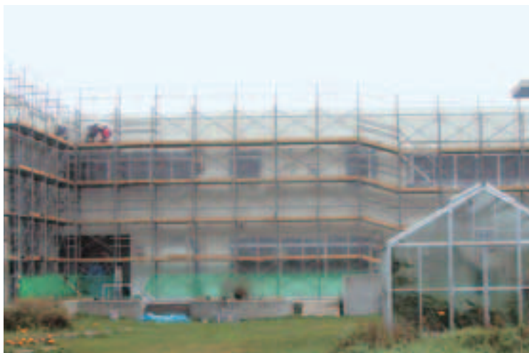
野付小学校の外壁の修理が進んでいます
