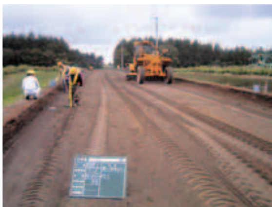
西春別・中西別線の改良舗装工事
