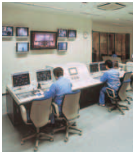
平成22年度から各町の負担が増加する広域ごみ処理場
