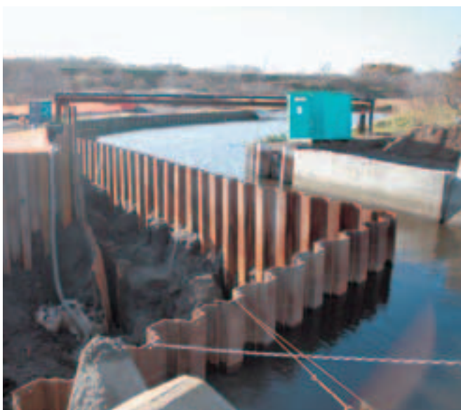
かけかえ工事が進む尾岱沼戸春別橋
