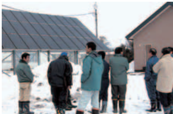
平成21年度に助成措置で設置した太陽光システムは42件
