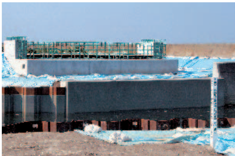
上部構造の建設工事が始まった戸春別橋
