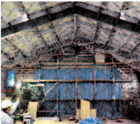
22年4月1日現在の学校耐震化率は全国73.3%・全道60.6%・当町79.7%（耐震工事が進む中西別小体育館）
