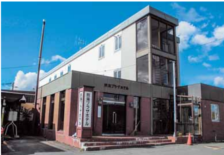
寄宿舎となる予定の旧別海プラザホテル
