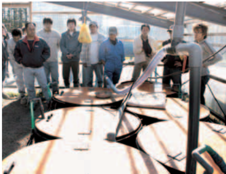
すでに取り組んでいる活性汚泥法による雑排水処理施設
