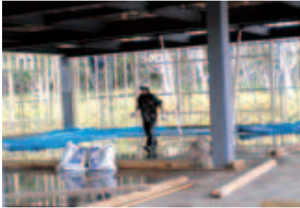
高台に建設工事が始まった床丹地区避難施設
