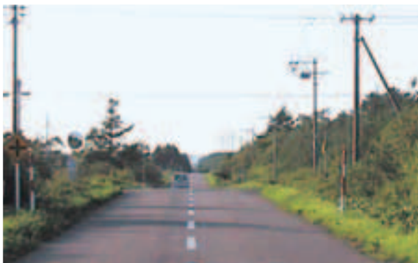
交通事故を出さないためにも総点検が求められる危険な交差点
