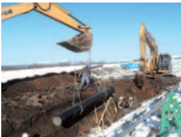
石綿管から塩化ビニール管へのとりかえが進む
