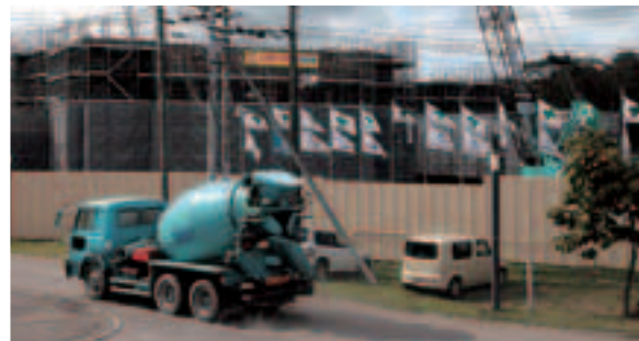
建設工事が進む新町立別海病院
