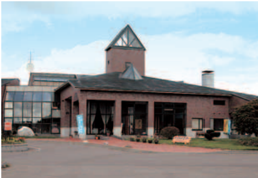
配管の修理工事が必要となった郊楽苑
