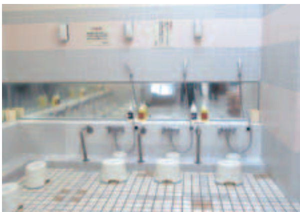
配管の修理が完了した郊楽苑
