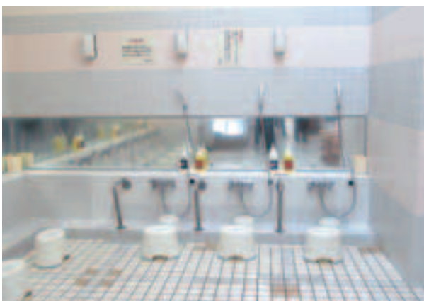
配管の修理が完了した郊楽苑
