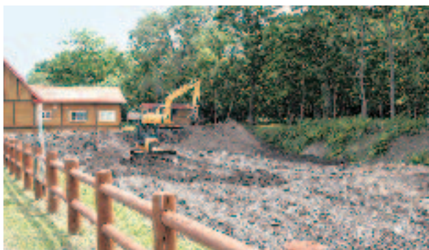
共生型福祉施設の建設工事
