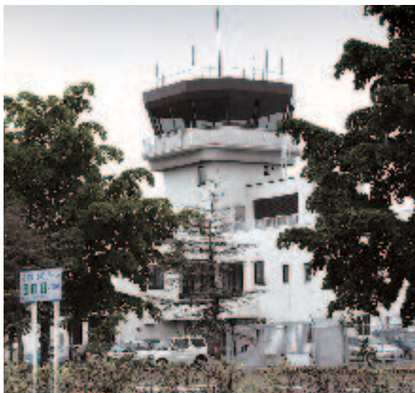
空の安全安心のため活躍する中標津空港管制塔
