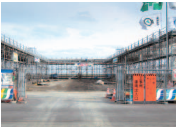
産業建設常任委員会が視察した尾岱沼漁港改良工事
