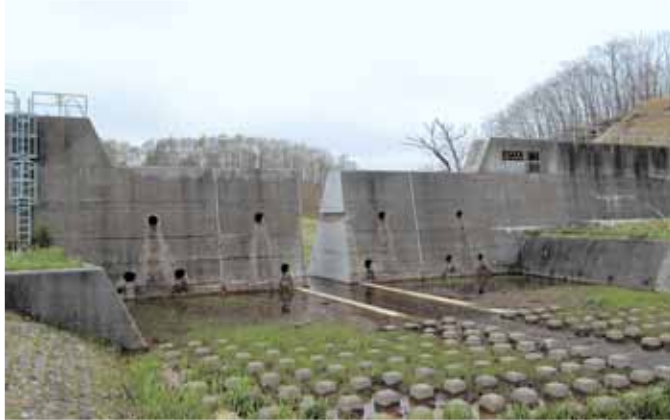
スリットが入った楓沢砂防ダム
