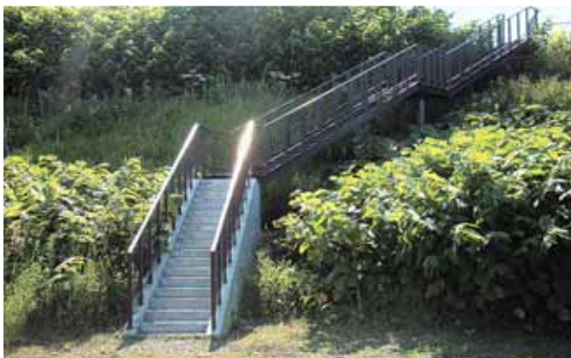
尾岱沼地区急傾斜地に設置された避難階段
