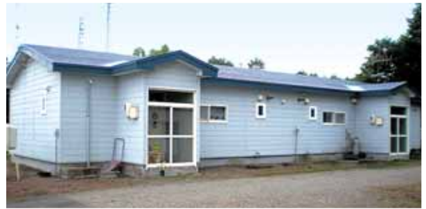
合併浄化槽が設置される中西別地域振興住宅
