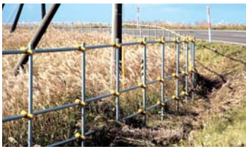
交通事故防止に役立っているエゾシカの飛び出し防止柵
