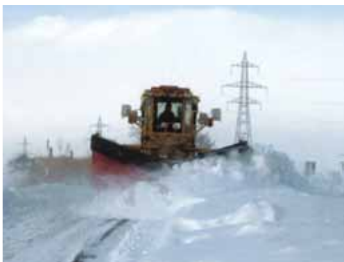
冬の安全を確保する除雪作業
