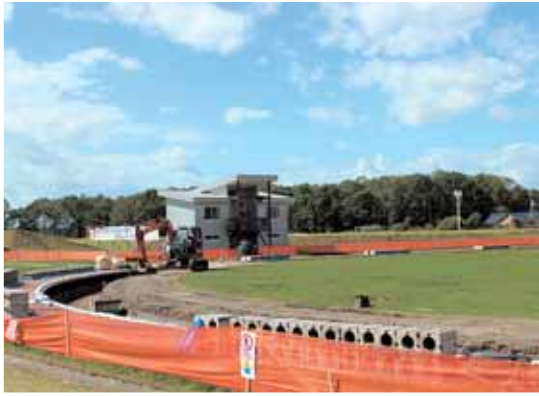
来春リニューアルオープンにむけて改修中の全天候型トラック
