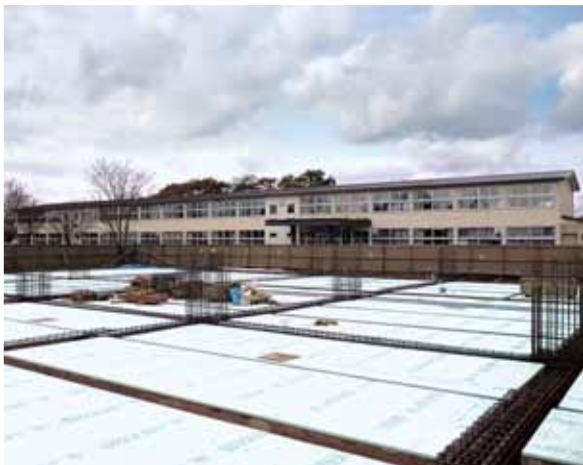
改築により耐震化される中春別中学校
