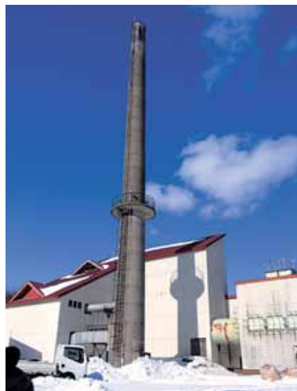
ダイオキシン対策で解体が遅れていた ごみ処理場の煙突
