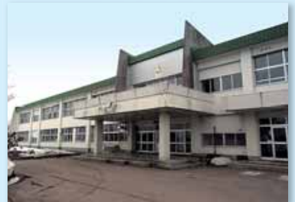
老朽化により建替えが計画される上西春別中学校の現校舎
