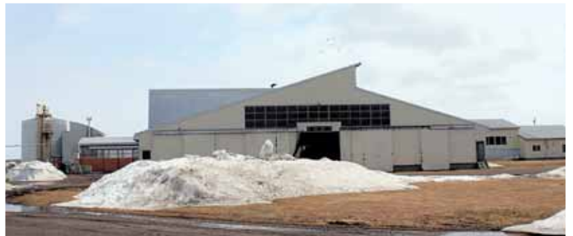
平成19年に動き始めた研修牧場のバイオガス施設
