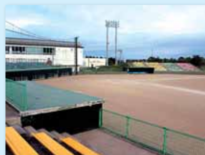
改修が少しずつ進む町営野球場
