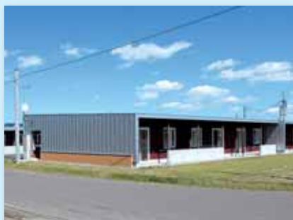
新しく建替えられ快適な生活空間になった公営住宅
