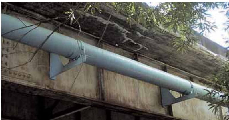
ひび割れを補修し、塗装を塗り替える第1床丹橋
