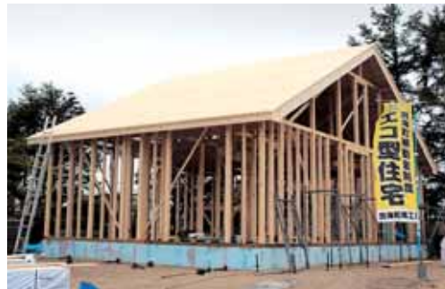
町の補助制度を活用し建設中のエコ住宅
