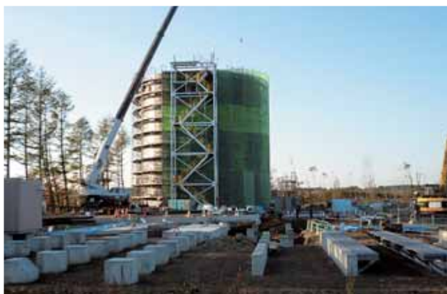
建設が進むバイオガス発電施設
