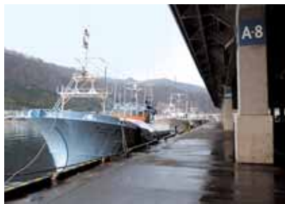
2階は駐車場となっている羅臼漁港
