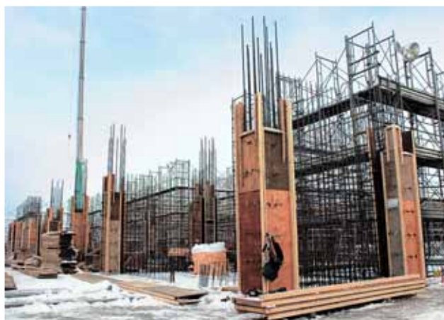
建設が進む特別養護老人ホーム
