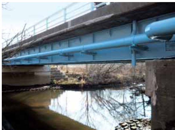
塗装を終え長寿命化が図られた橋（美原地区）
