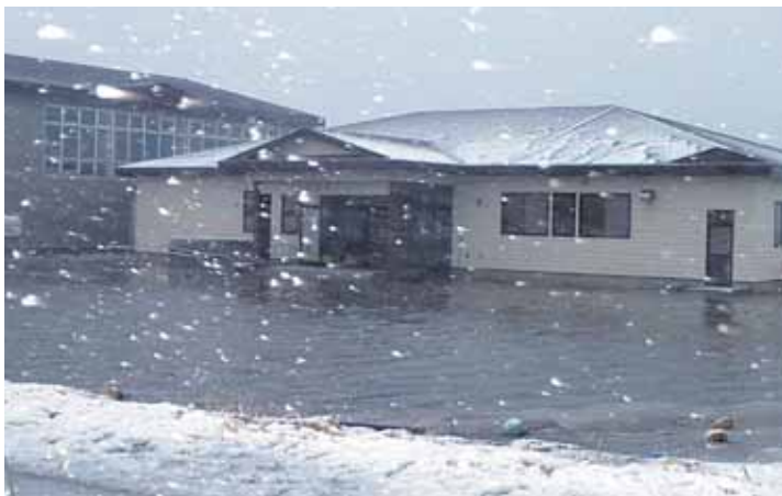
床下浸水した床丹会館
