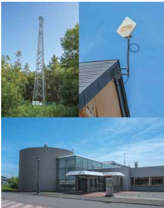
左上：無線中継設備 右上：家庭用の無線設備 下段：マルチメディア館
