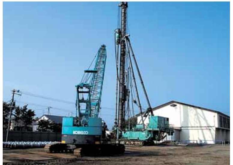
建設が始まった中春別中学校屋内体育館
