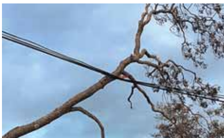
台風により電線にもたれかかる倒木
