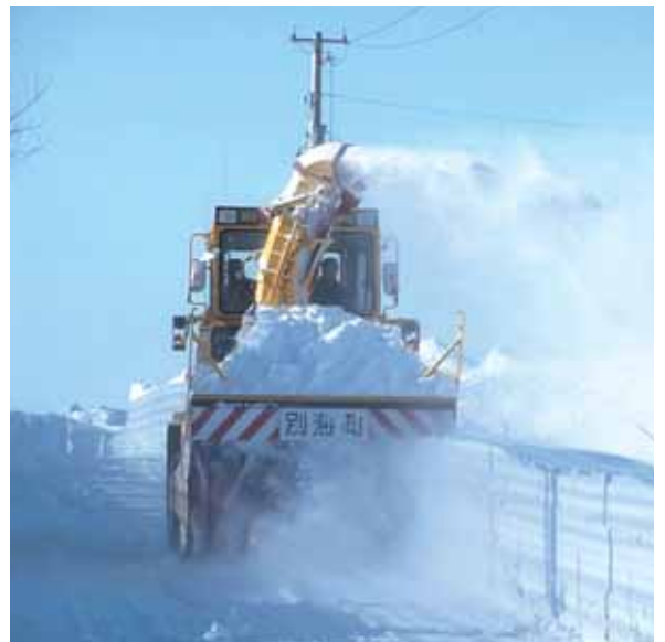
除雪作業中のロータリー除雪車
