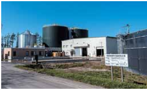
7月から本格稼働となったバイオガス発電施設
