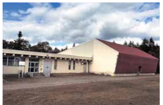
更新または耐震化が必要とされる別海浄水場
