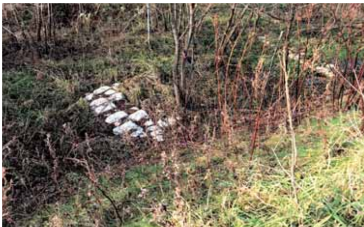
排水溝に設置されているホタテ焼成員の浄水施設
