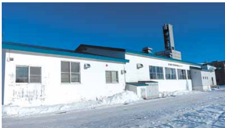
昭和44年に建設され築後50年に迫る給食センター
