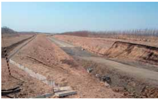
2019年開通予定の根室道路建設現場。災害などに対しても高規格道路の役割は大きく、ネットワーク化が進められている
