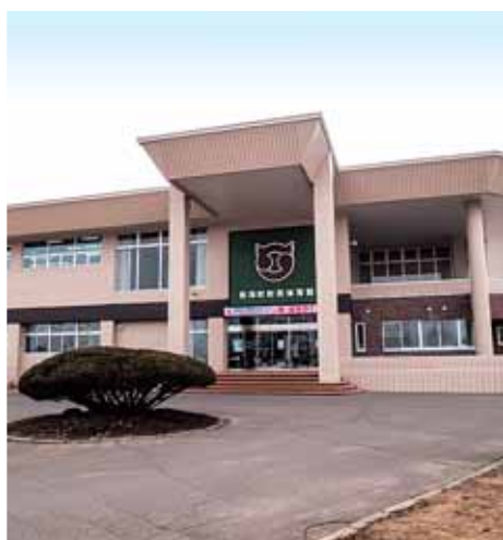
外装の改修を終え、今年には内装の改修が行われる
