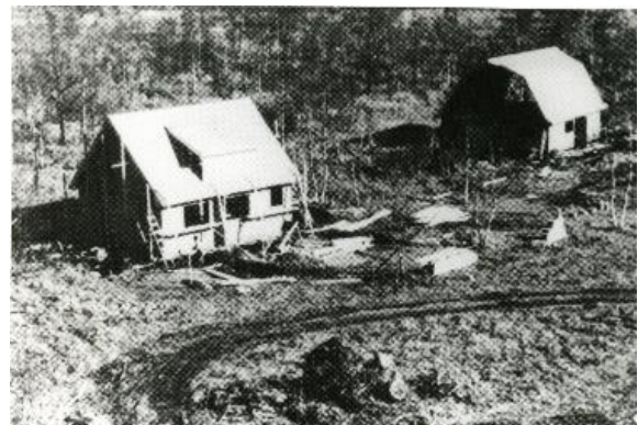
パイロットファームの住宅・牛舎
